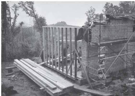
Montage de l'ossature primaire
