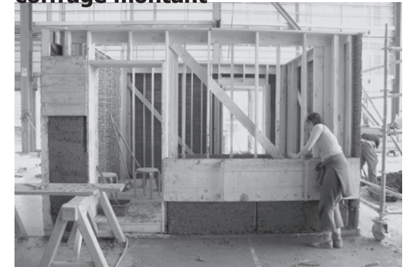
◀ 71 - Le remplissage en vrac par coffrage perdu
