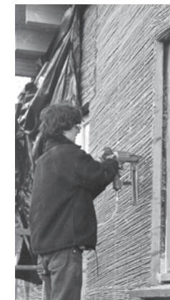
Installation du coffrage perdu
