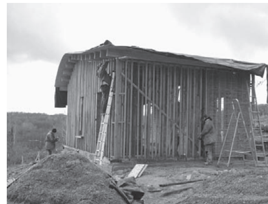
Installation du coffrage perdu
