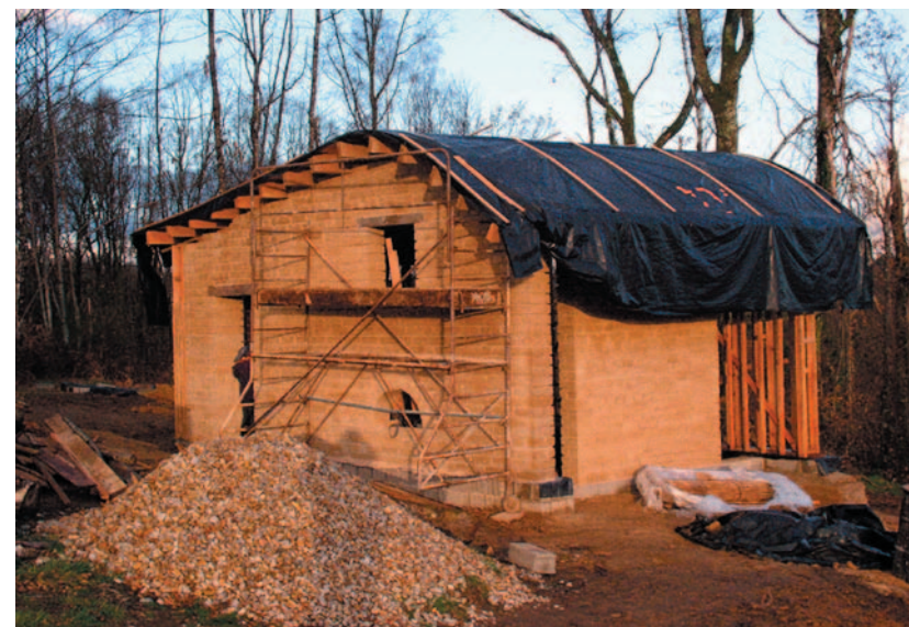
▲ 27 - Le pavillon terre crue. - nov. 2003 -
