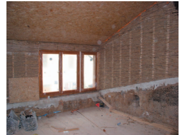
▶ 87 - les remplissages finis
