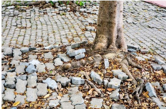
*Figure 9 : Racines détruisant un revêtement de pavés béton (source : treebuilders.eu)*
