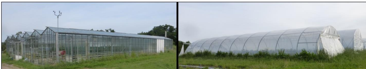
FIGURE 3 : DEUX TYPES D'ABRIS MARAICHERS : UNE SERRE MULTI-CHAPELLE EN VERRE ET UN TUNNEL FROID (CREDITS PERSONNELS)
