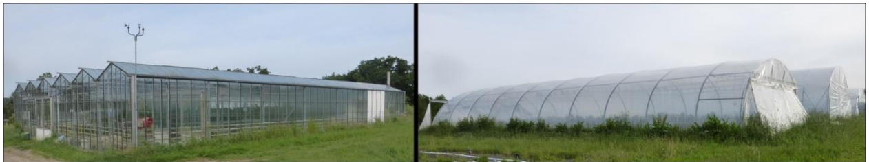
FIGURE 3 : DEUX TYPES D'ABRIS MARAICHERS : UNE SERRE MULTI-CHAPELLE EN VERRE ET UN TUNNEL FROID (CREDITS PERSONNELS)
