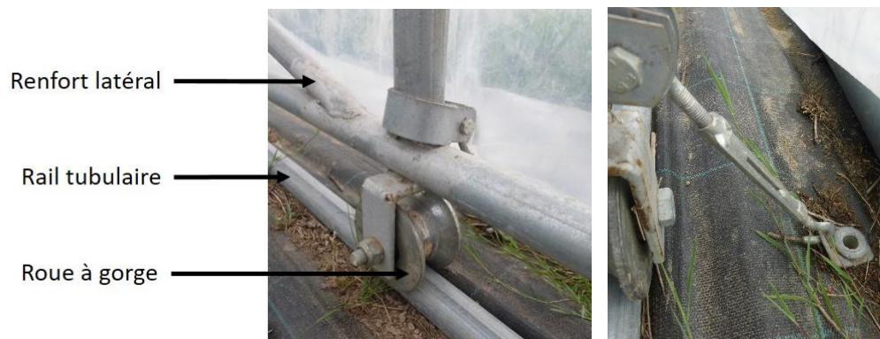
FIGURE 13 : ELEMENTS DE MOBILITE (GAUCHE) ET AMARRES A PERCUSSION (DROITE) DU TUNNEL MOBILE (CREDITS PERSONNELS)
