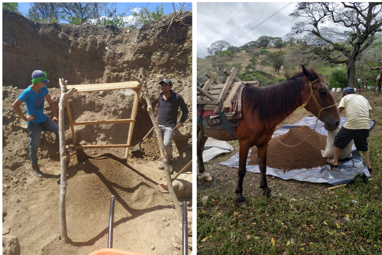
06. Pour réaliser la banque de matériaux, on a cherché des voisins dans le quartier, ce qui a rendu le processus d'extraction-séparation-stockage de la terre. Tous dans le même terrain.
