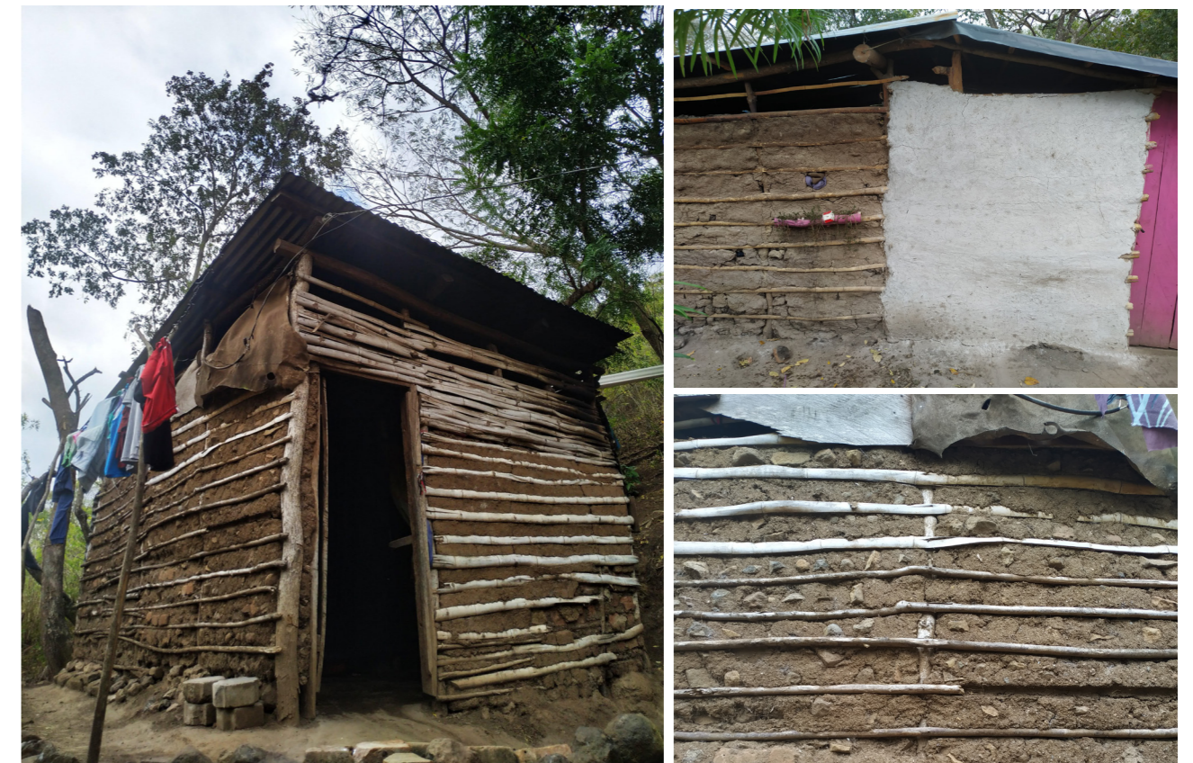
02. Logements précaires où l'on observe la persistance de la technique de construction du taquezal, région de San Dionisio
