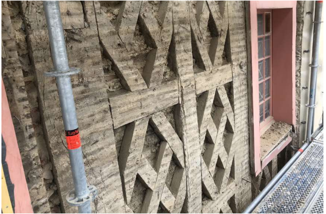
losanges de la façade côté rue Saint-Louis, 20 place des lices
