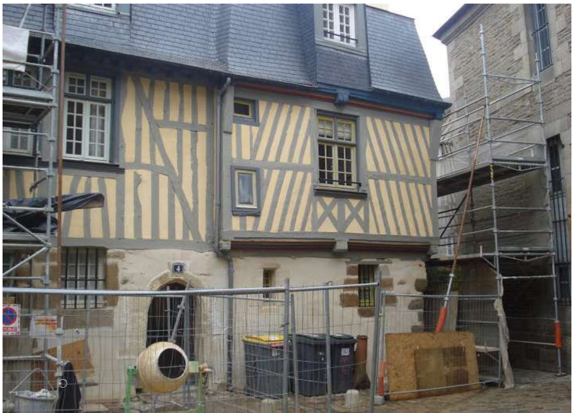
rue de la Psalette, enduit de torchis, Argilus
