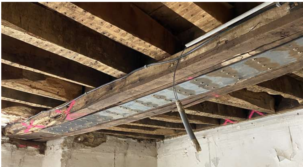
renfort de poutre maîtresse par plat métallique, 8 rue Hoche, O. Delamotte
