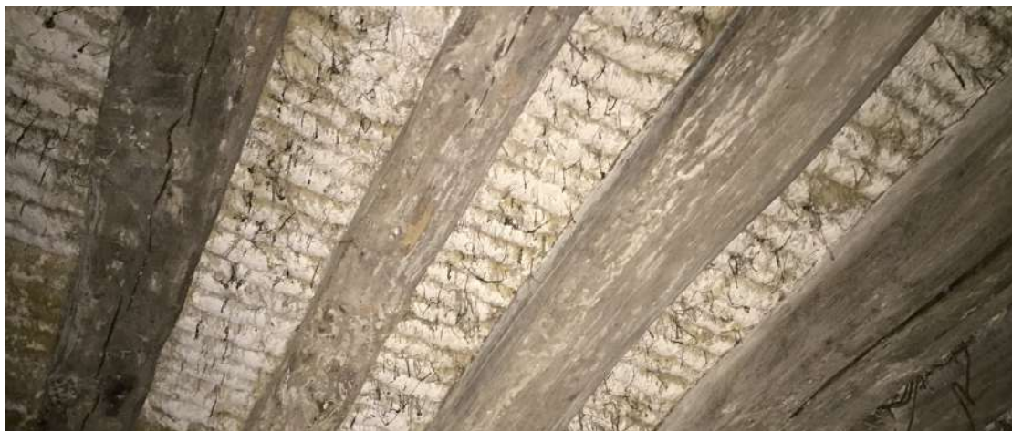
plancher en quenouilles, 20 place des Lices, A. Masson
