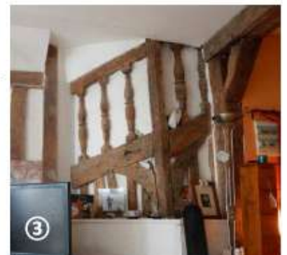
Vue sur l'escalier qui était à l'air libre à l'origine, ainsi qu'un poteau du bât. ajouté
