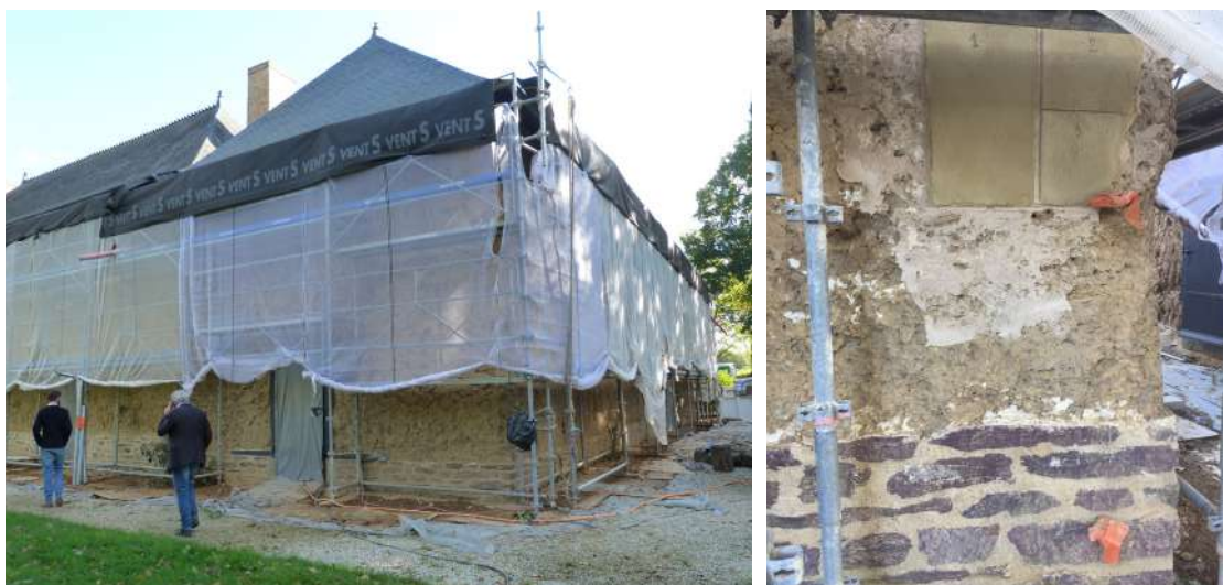
longère sous sa robe échafaudée & échantillons d'enduit à la chaux, D. Perau
