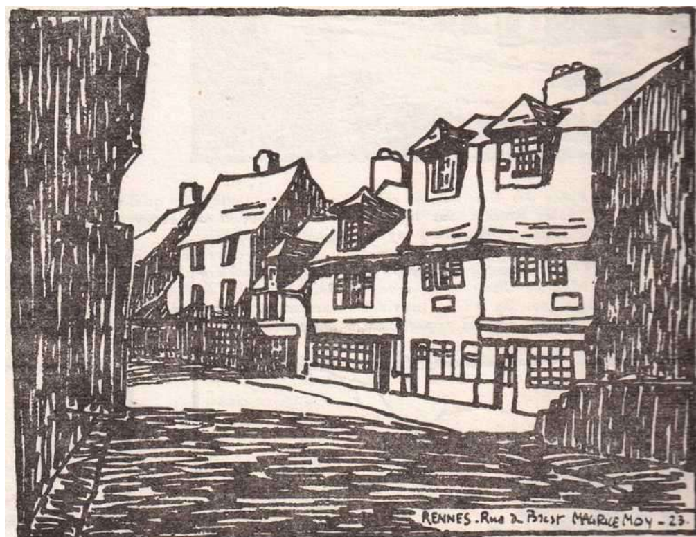
rue de Brest avant démolition, 1923, Maurice Moy
