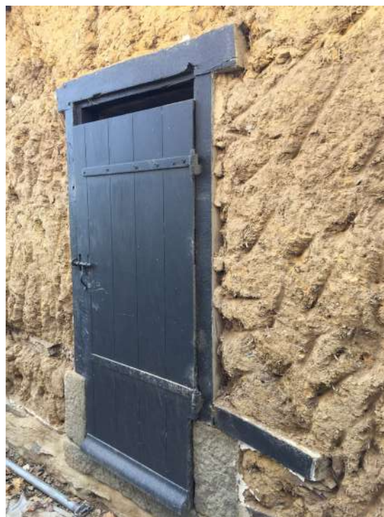
longère en bauge après la dépose des enduits, Pacé
