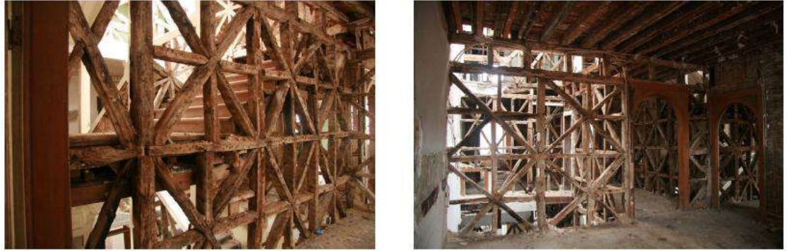
Figura 1: Gaiola Pombalina após remoção da alvenaria
