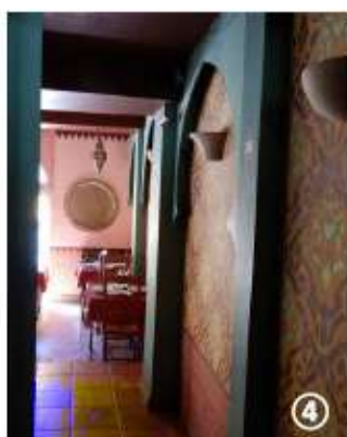
Vue (au RdC) sur les poteaux encoffrés, contre le mur du n°22
