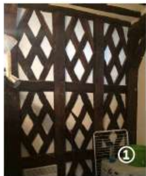
Vue sur l'ancienne façade à croisillons et un début de poutre qui longe le n°22
