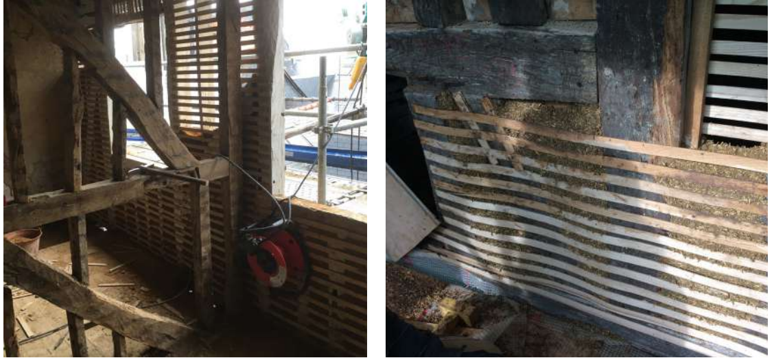
remplissage terre (14 rue Victor Hugo) et terre-chanvre (7 place Sainte-Anne), A. Masson
