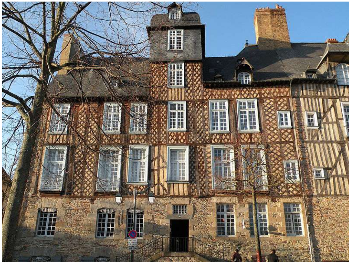
hôtel Racapé-de-La-Feuillée avant sa mise en peinture, 28 place des Lices, Pymouss
