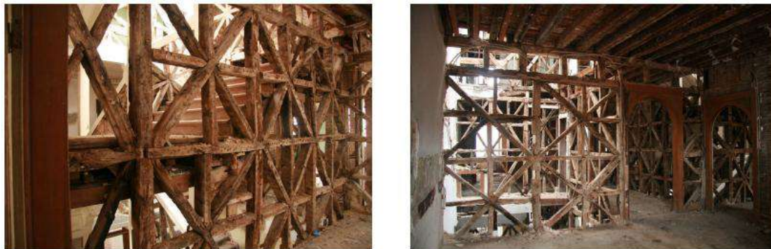
Figura 1: Gaiola Pombalina após remoção da alvenaria
