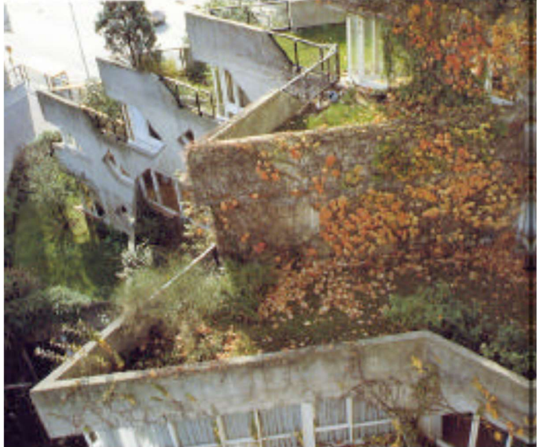
Figure 7 : toits terrasses en escalier du bâtiment de Renaudie
