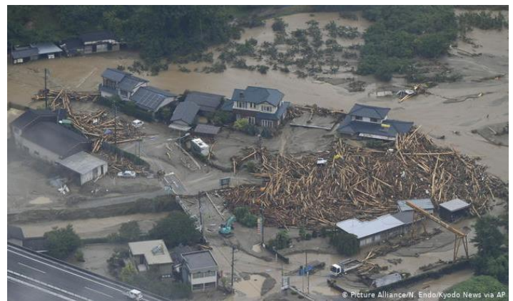
Figure 0-2 : Débris mobilisés par les cours d'eau à la suite des pluies torrentielles de juillet 2017 dans la Préfecture de Oita (Japon)
