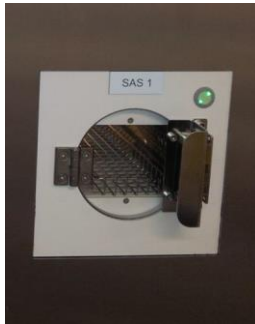
Figure 6 : Sas rapide porte extérieure
