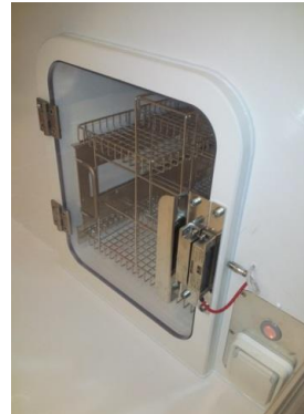
Figure 5 : Grand sas porte intérieure
