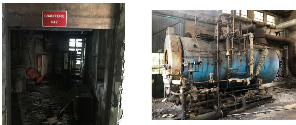
Figure 9 : État actuel de l'ancien système de chauffage
