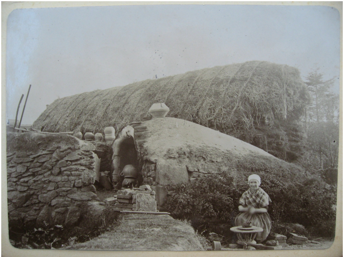
Fig. 23 : Potière de Lannilis devant son four. Source : Alain Croix, La Bretagne des photographes , PUR, 2012. On note, à l'entrée du four, des poteries qui s'emboîtent formant la voûte. On peut également voir la couche de sable qui protège le four de la pluie, ainsi que le tas de fagots de lande en arrière plan.
