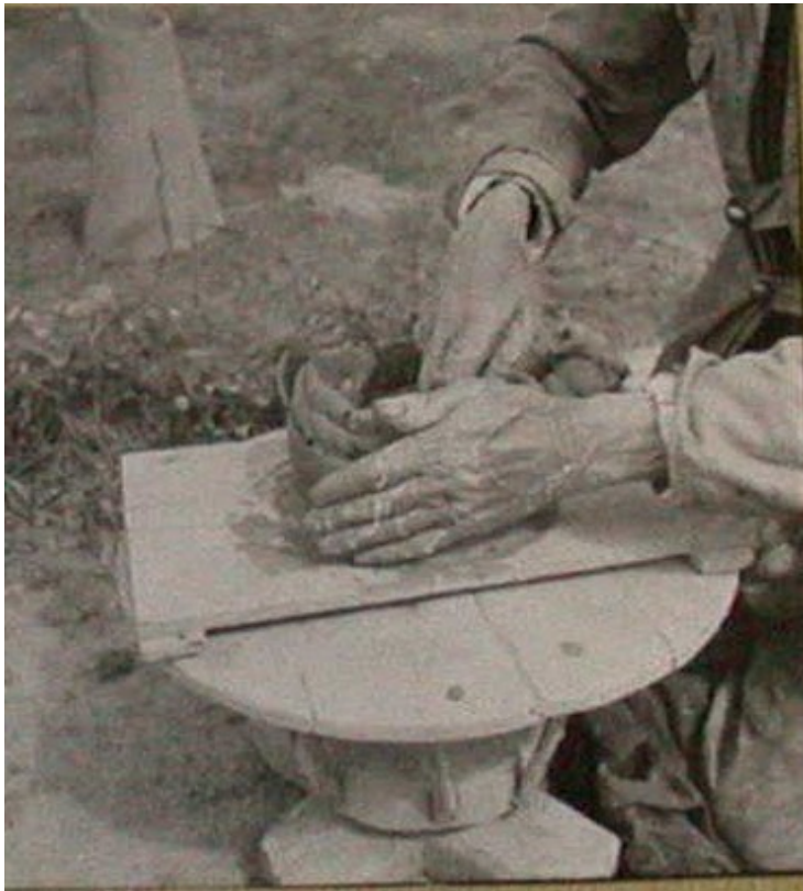
Fig. 28 : Montage au colombin. Source : MNATP. Photo 48 34 28
