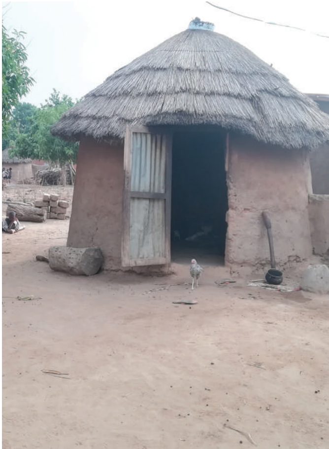
◀ Toiture en paille au village Chantier, à 12 km de Parakou au nord du Bénin, avril 2018
