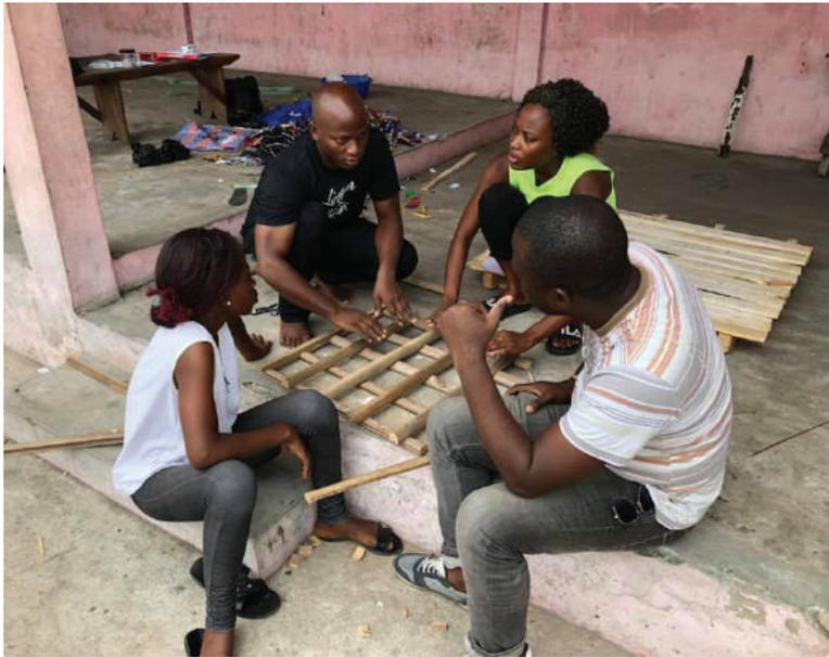
◀ Fabrication d'une structure de faux-plafond en branches de palmier
