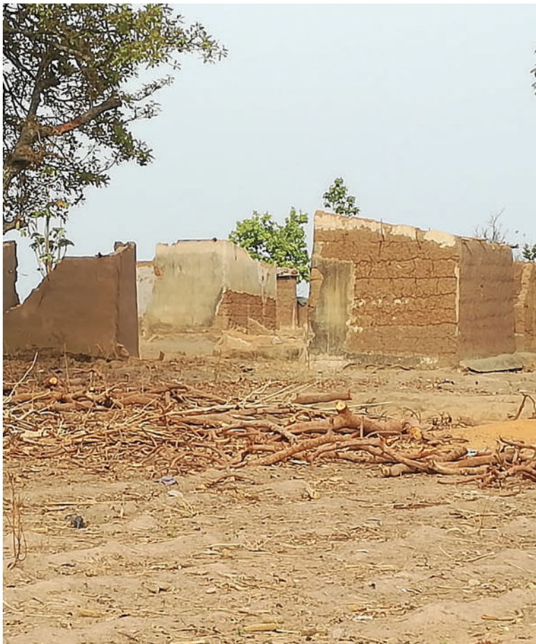
◀ Au village Chantier, observation de constructions et de besoins en matériaux
