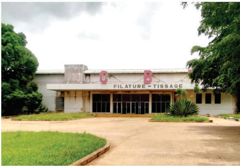
◀ Façade de la Compagnie Béninoise de Textile à Lokossa, unique usine textile de coton dirigée par des chinois.
