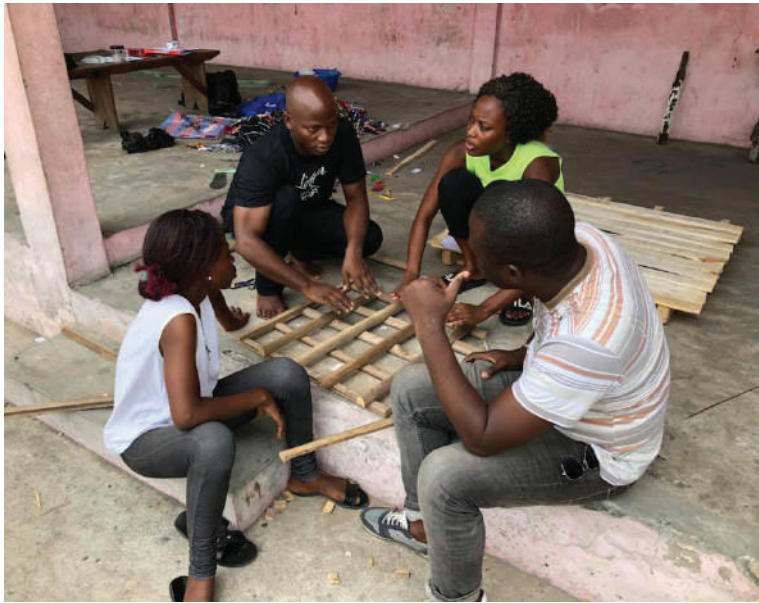
◀ Fabrication d'une structure de faux-plafond en branches de palmier ©L'Atelier des Griots
