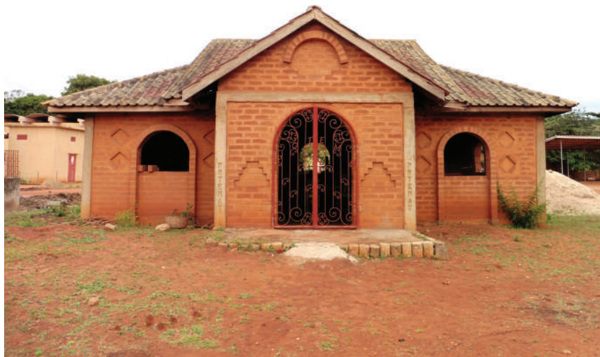
Le bâtiment du POTEMAT en BTC et tuiles
