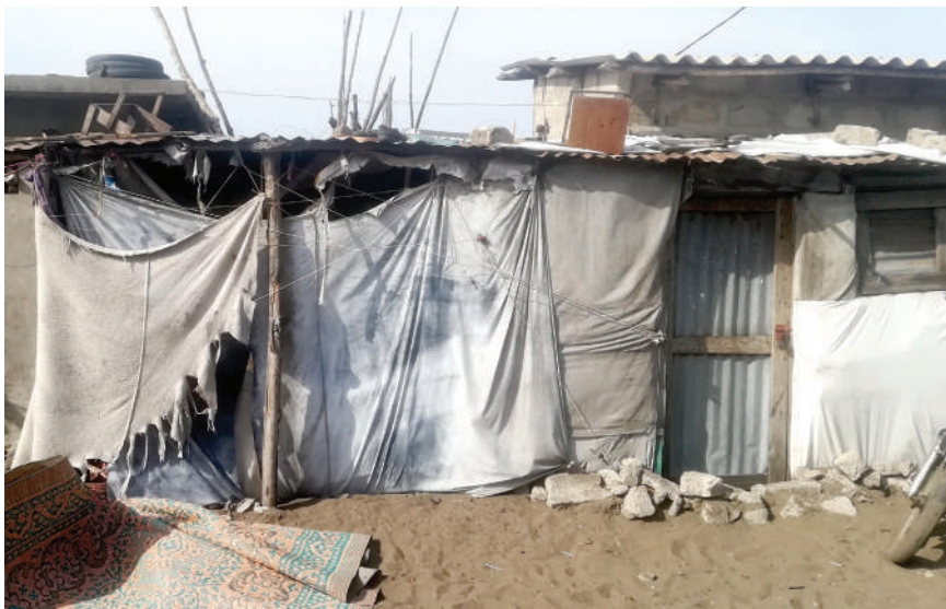
◀ Habitat auto-construit photographié dans une rue d'Akpakpa Dodomey Enagnon à Cotonou le 14 avril 2018
