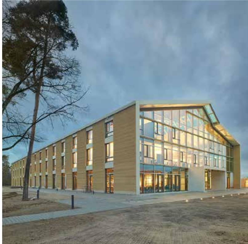
Les murs-trumeaux permettent de s'affranchir des règles de dimensionnement des baies.
