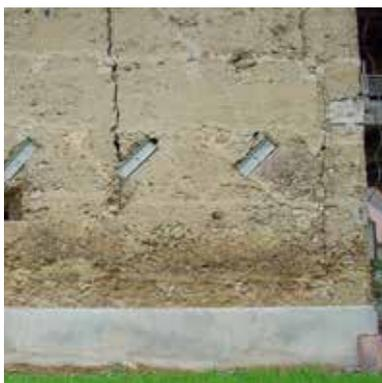
blèmes. Elles sont réalisées au moyen de vis avec chevilles ou vis à béton suffisamment longues et à bonne distance des arêtes saillantes. A titre d'exemple, le *Dossier technique lié à l'ATEX de type A n°2588\** préconise d'une part une distance de l'arrête saillante supérieure à 15 cm et au double de la profondeur d'ancrage et d'autre part une distance entre fixation supérieure à 20 cm et au quadruple de la profondeur d'ancrage.
