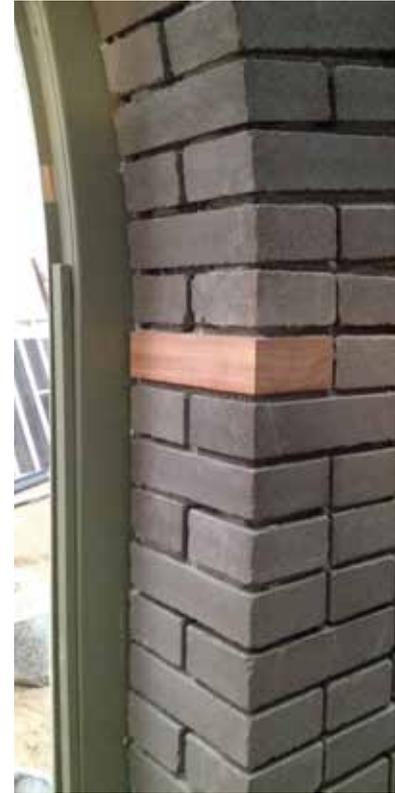
Le *Manuel de construction : La maçonnerie en terre crue\** conseille de prévoir un espace de 5 mm au-dessus d'une baie de porte dans un mur en BTC.
