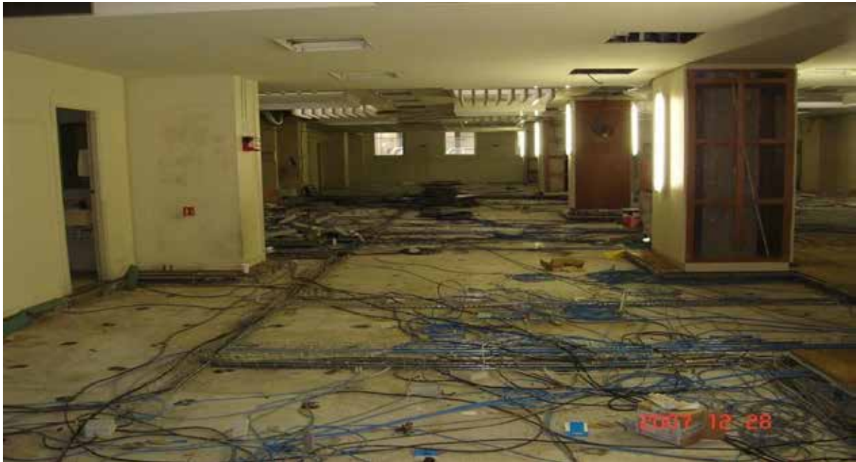
Le début des travaux à partir d'une configuration en open space .
