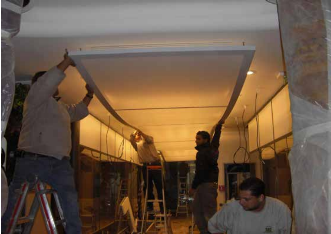
Mise en place du velum au plafond de l'allée centrale.
