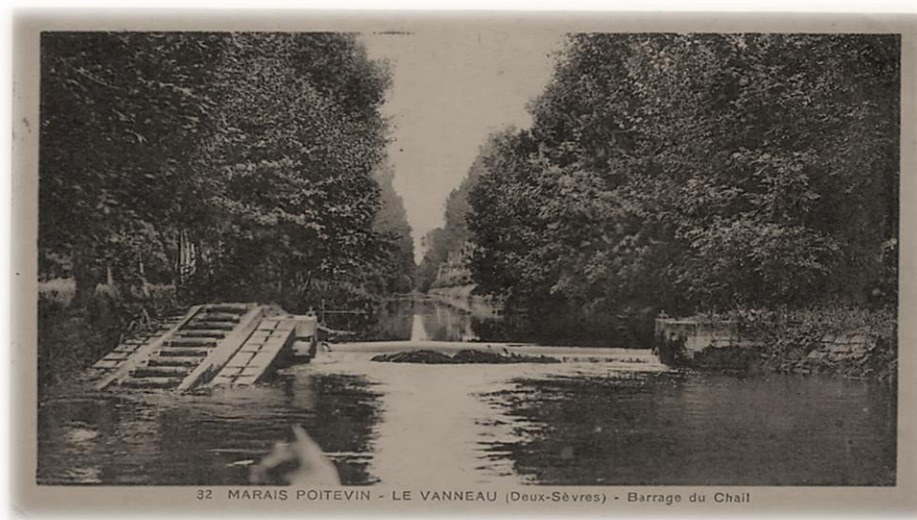
54 / Le Vanneau, barrage du Chail
