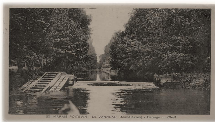
54 / Le Vanneau, barrage du Chail
