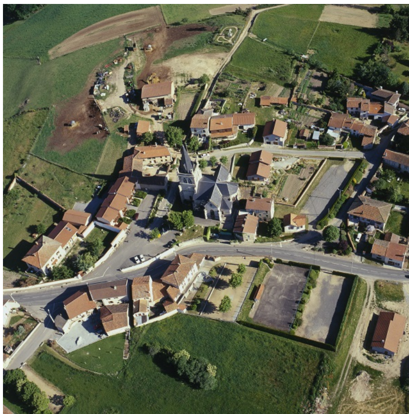
Illustration 5: Vue aérienne du bourg de St-Sixte, depuis le sud-est. Eric Dessert, région Auvergne-Rhône-Alpes, Inventaire général du patrimoine culturel.
