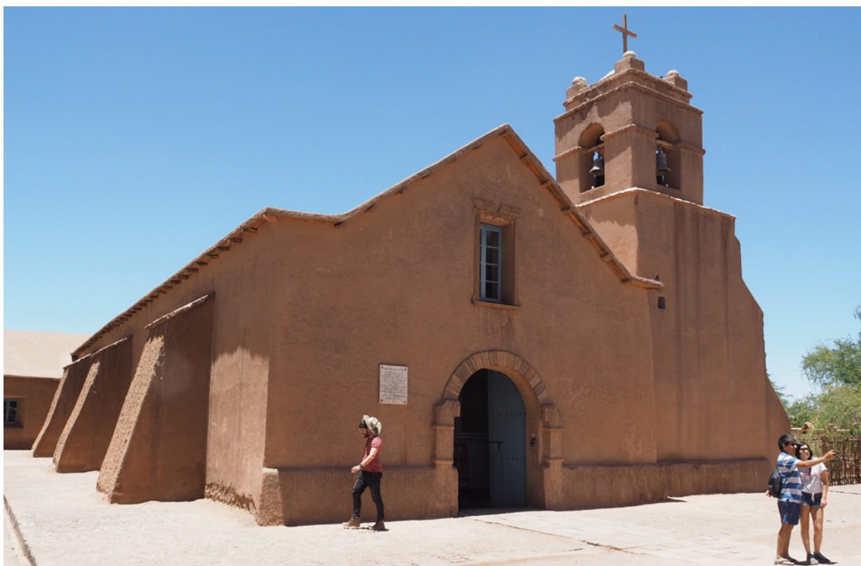
L'église de San Pedro, avant les travaux de réparation
