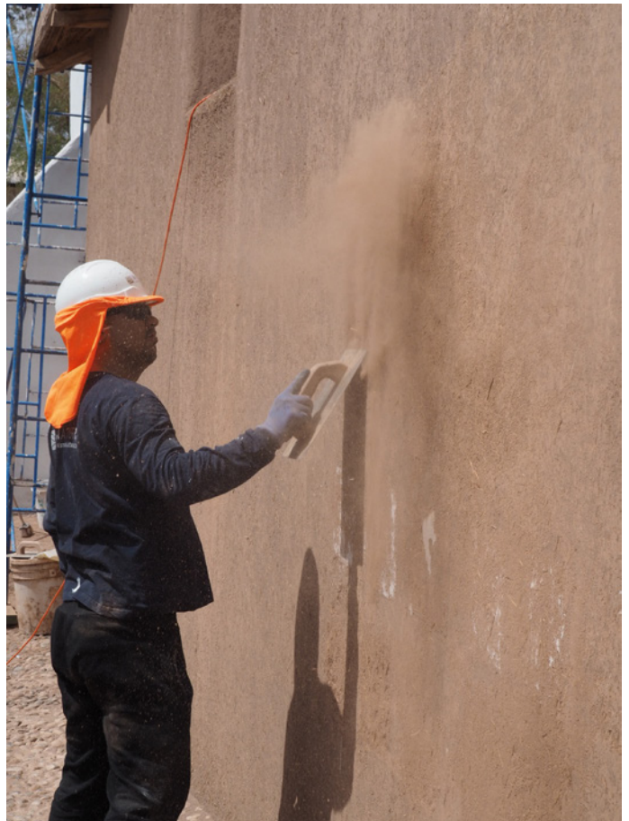
Nettoyage des surfaces avant d'intervenir
