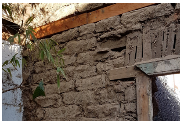
Colegio de Arquitectos / La Serena
