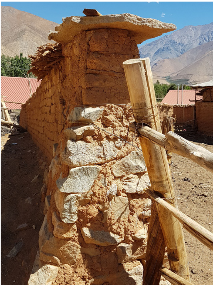
Mur d'enclos / Horcon
