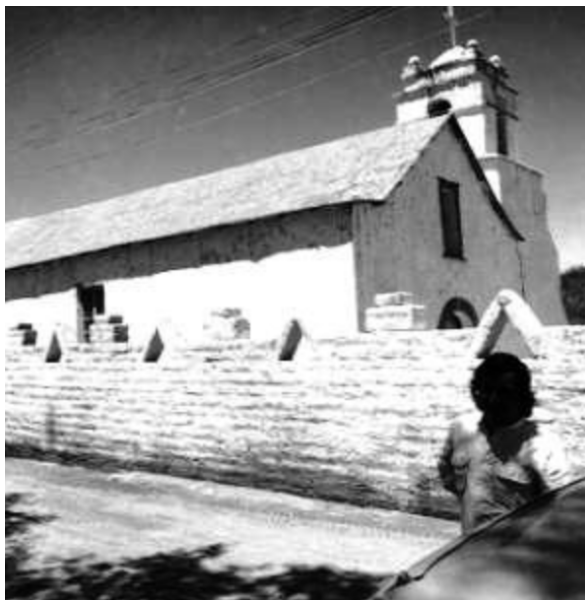
Mur d'enceinte, côté Est, environ 1990. Source : cl.r.cl
