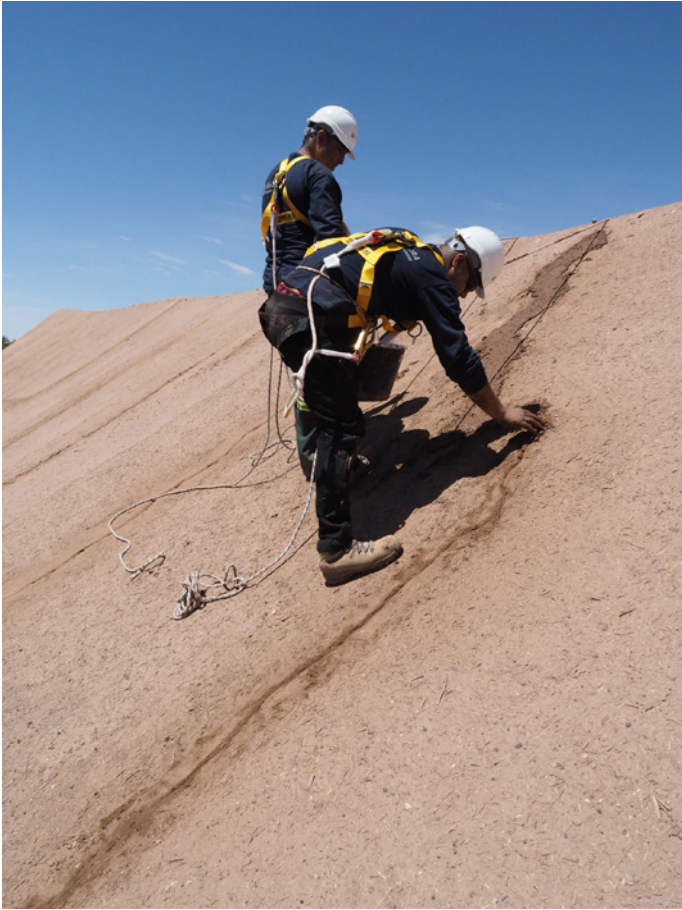
La réparation des fissures du toit à la main.
