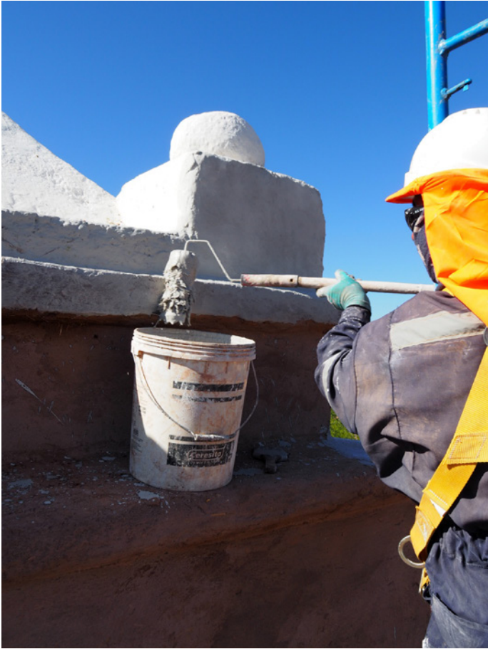
Application au pinceau de la chaux sur le clocher. Deux équipes travaillent en même temps sur la façade Nord
