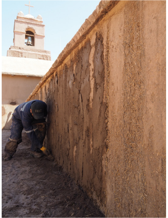
Reprise du contrefort massif côté Ouest
