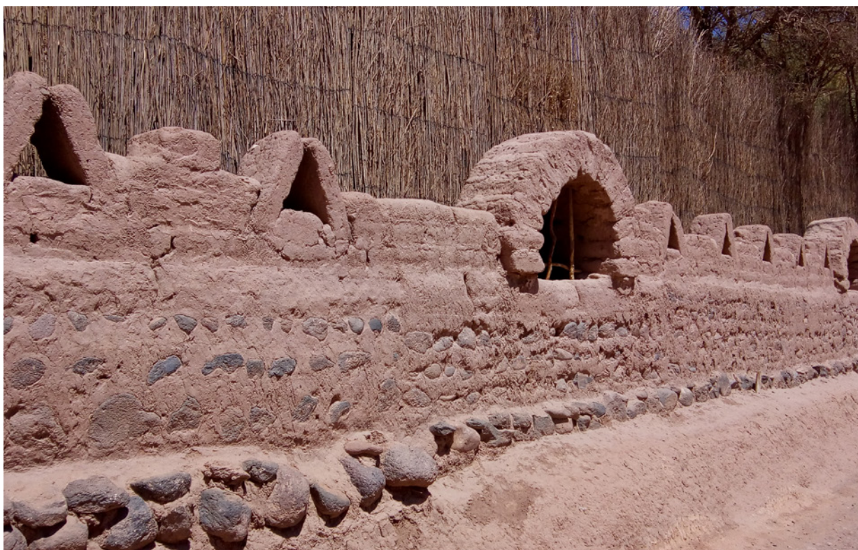
Un mur d'enceinte du village de San Pedro de Atacama
