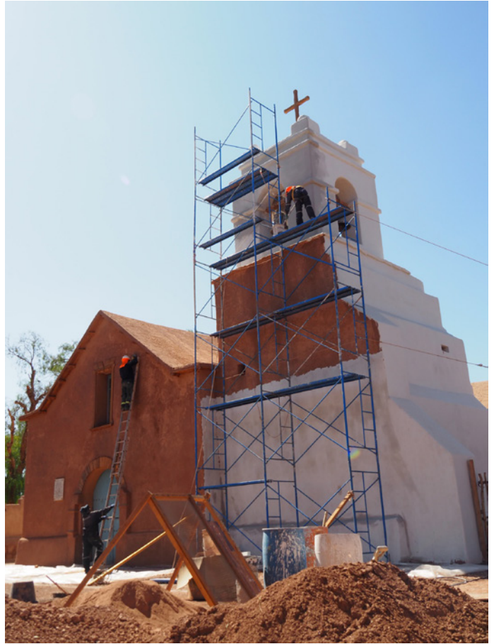
Application au pinceau de la chaux sur le clocher. Deux équipes travaillent en même temps sur la façade Nord
