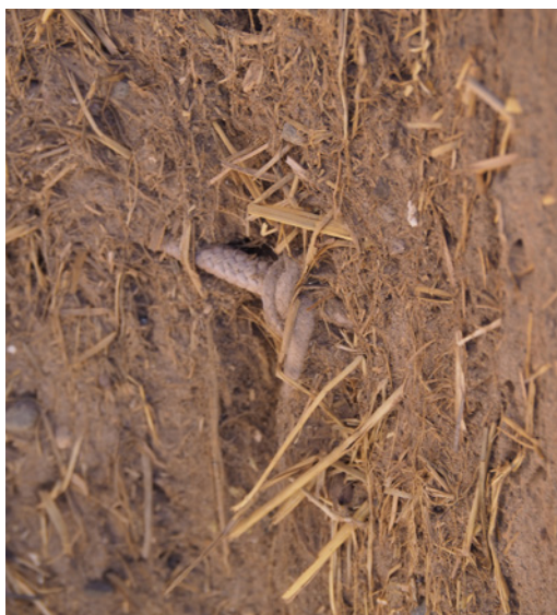
Restes de corde, liant les adobes, comme une couronne structurelle
