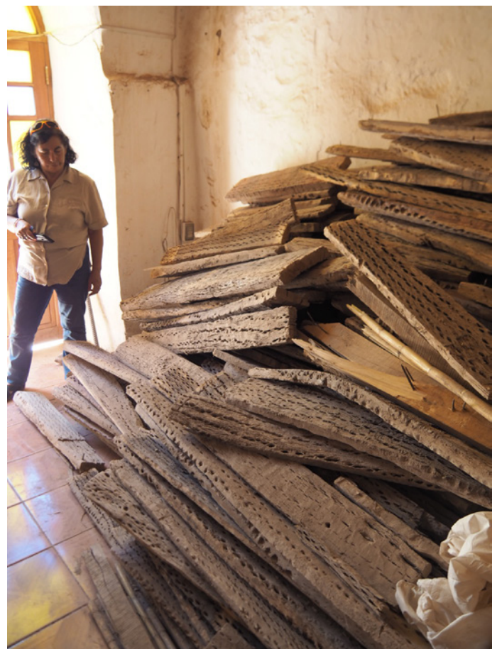
Les solives de cactus entreposées en attendant la reconstruction du toit de l'église de Toconao.
