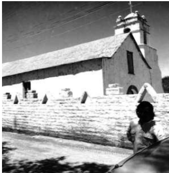
Mur d'enceinte, côté Est, environ 1990. Source : cl.r.cl
