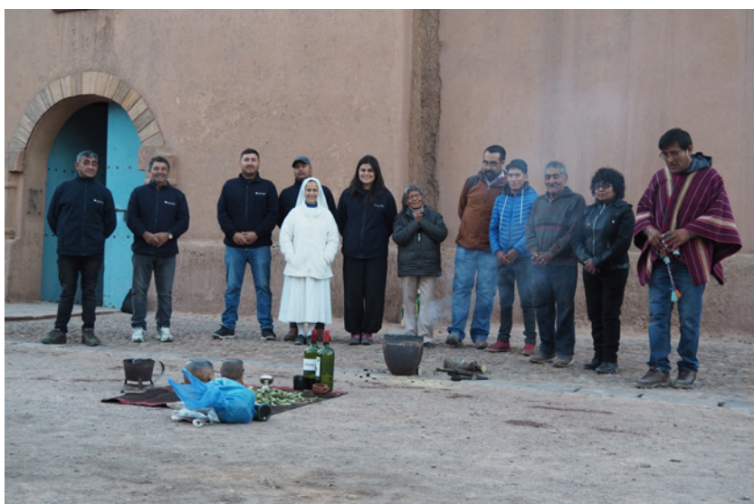
Cérémonie de début de chantier, avec le chef des communautés indigènes - 6 janvier 2020
