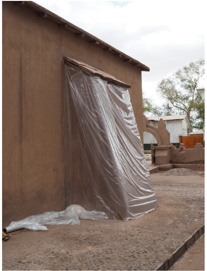
Protection provisoire sur les contreforts réparés façade Est.
