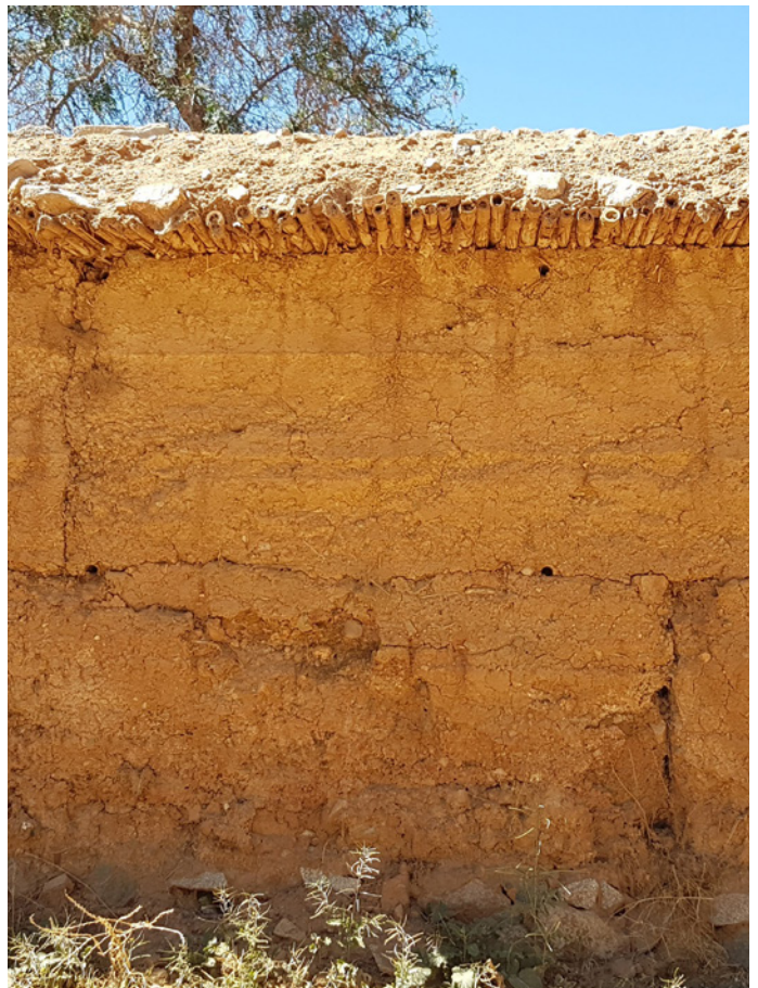
Mur de délimitation de maisons / Tapial / Horcon
