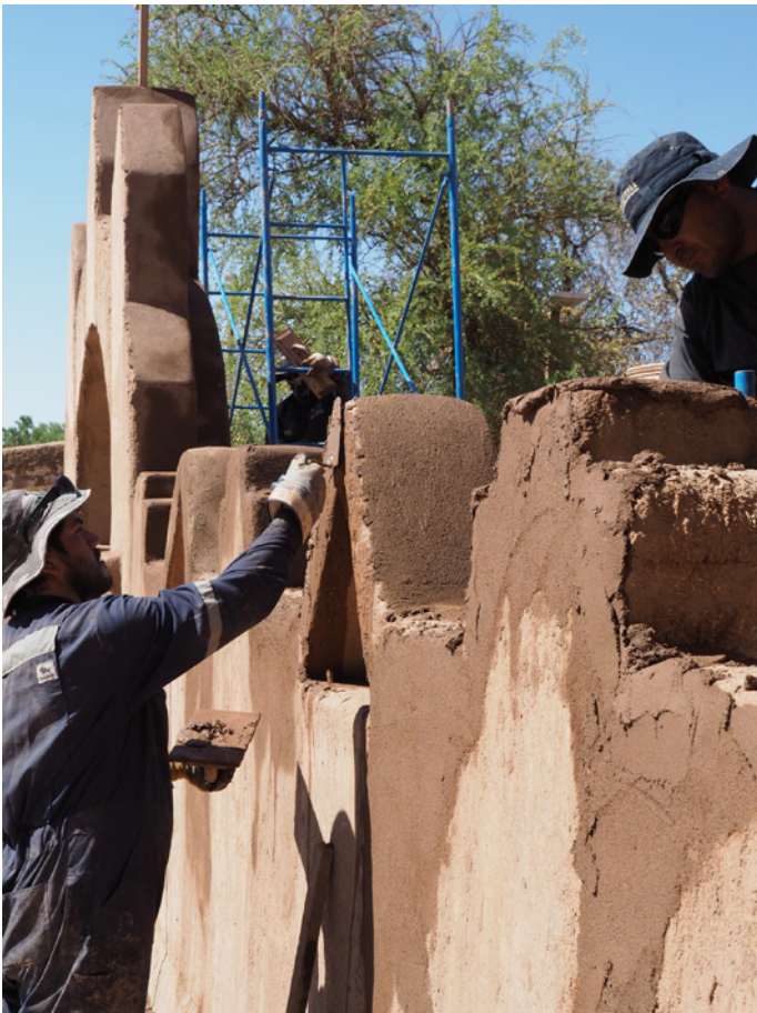
Reprises des motifs de culture Likan Antai, mur d'enceinte.
