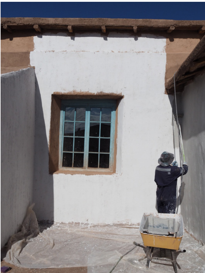
Peinture à la chaux sur la façade Ouest.
