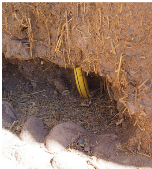
Restes de corde, liant les adobes, comme une couronne structurelle
