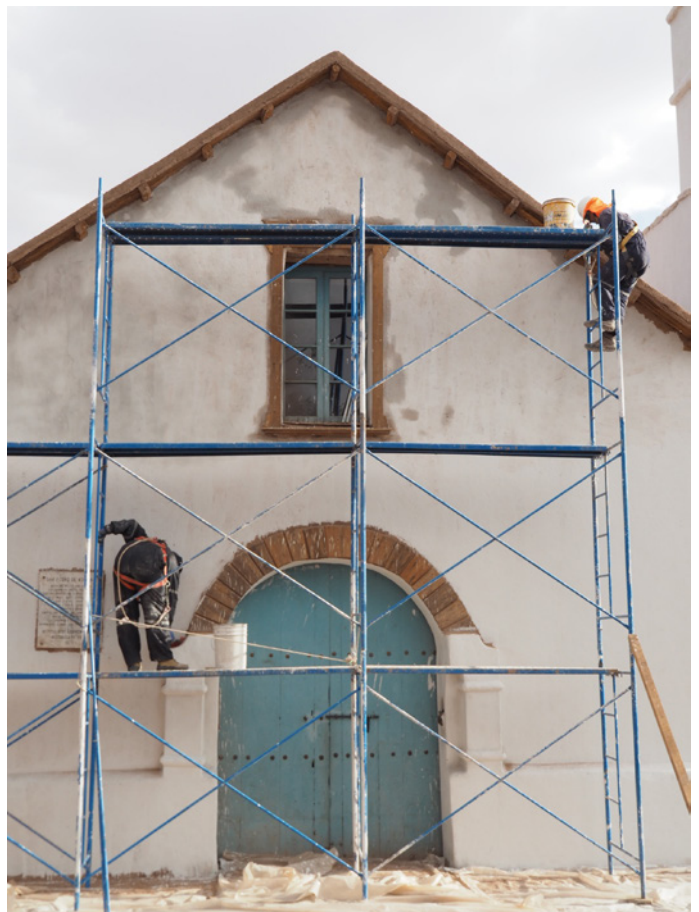
Tâches d'humidité persistantes en dessous du toit.
