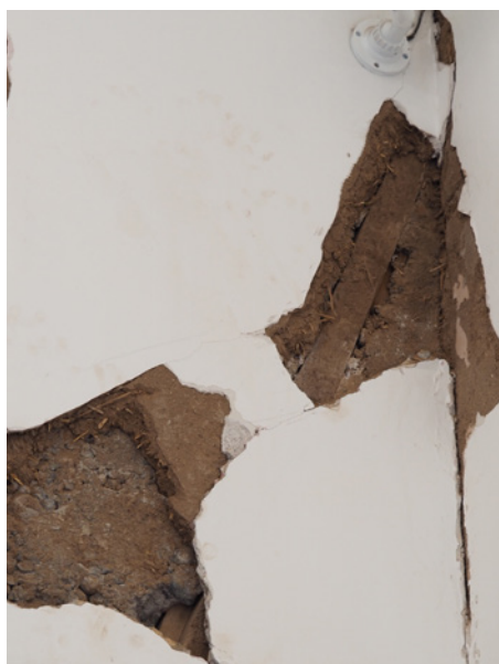
Détails d'interventions non adaptées découvertes à la Casa Las Palmeras - La Serena
