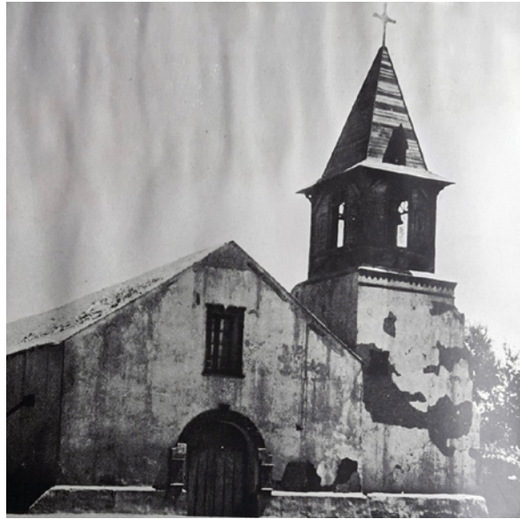
Clocher en bois, en 1931. Source : enterreno.com
