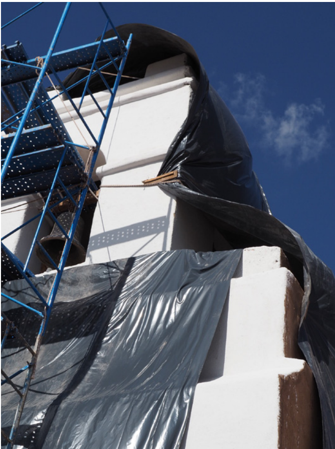
Protection sur le clocher peint à la chaux.
