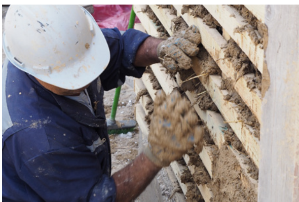
Remplissage avec un mélange terre-paille une structure bois / Coquimbo
