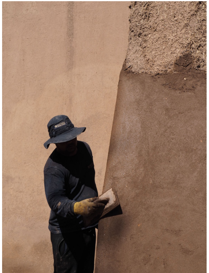
Lissage à la taloche de la surface d'un des contreforts.
