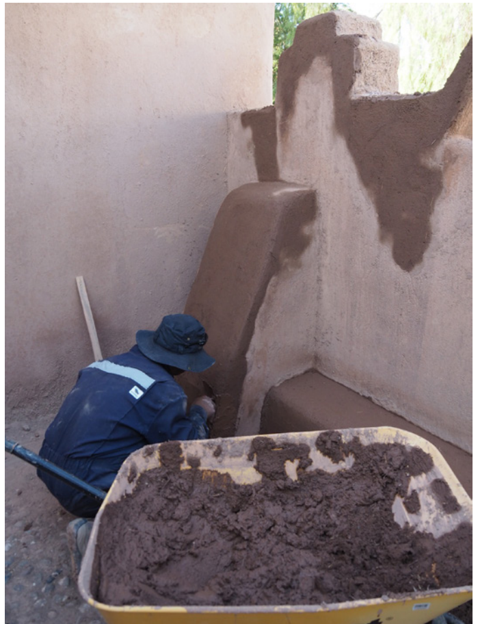
Reprises du mur d'enceinte avec ses petits contreforts
