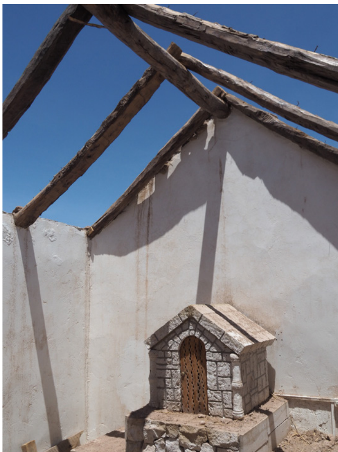
Eglise de Toconao, dont le toit a été détruit à causes des pluies.
