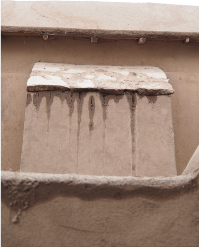
Effet des pluies du cinquième jour de chantier.
