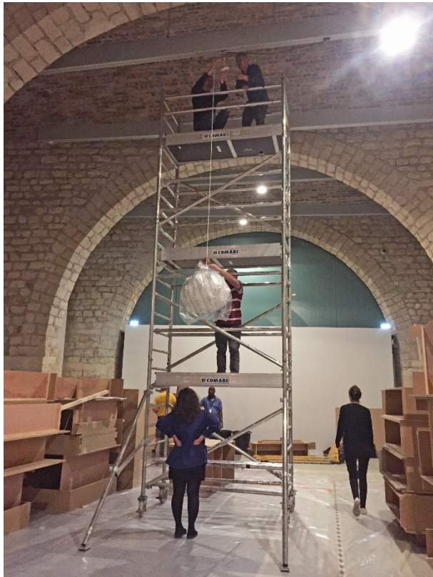
Figure 23. Installation et raccordement électrique
