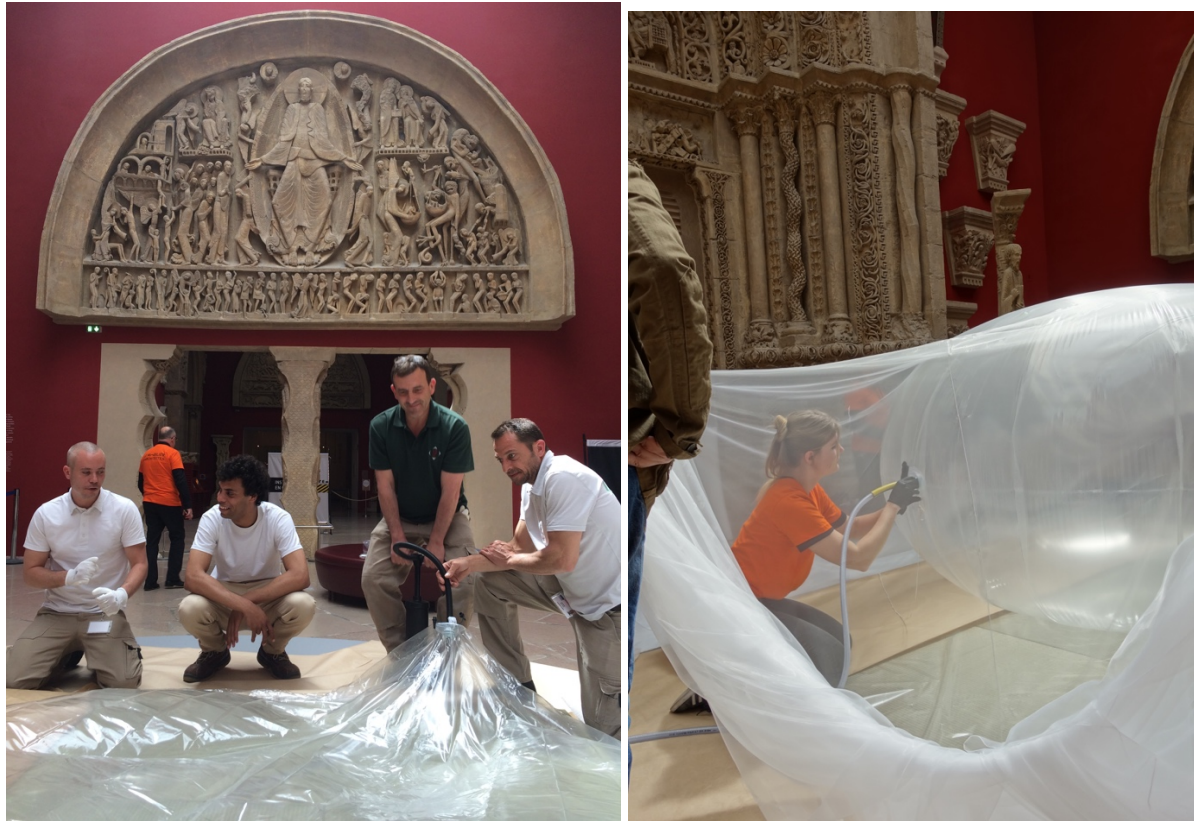
Figure 31. Gonflage de la lentille du Pavillon de Thé de Kengo Kuma à l'air puis à l'hélium
