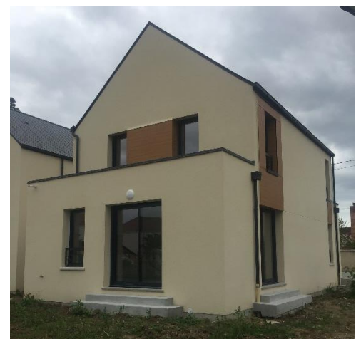
Figure 24 :ZAC de la Cerisaille à Saint Jean le Blanc, Pauline DEVAUX, toit-terrasse, marche d'accès
