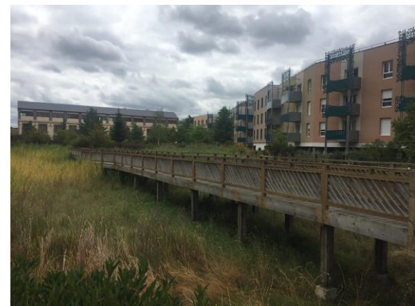
Figure 23 : Quartier Matra, bassin de rétention d'eau, source Pauline DEVAUX
