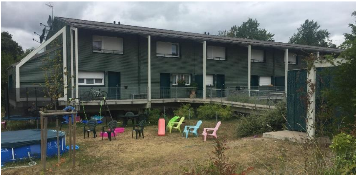
Figure 29 : Habitation à Matra. Les éléments importants se trouvent hors risque, donnant place aux nouveaux usages du RDC - terrasse, cuisine d'été, espace de jeux ou de bricolage ...
