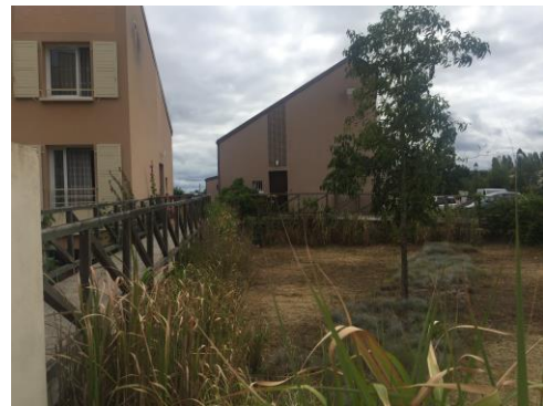
Figure 25 :rampe d'accès aux logements Matra, source Pauline Devaux
