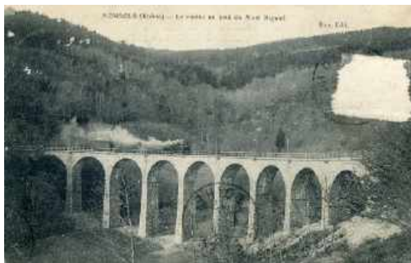
Viaduc du Mont Saint-Rigaud du chemin de fer en 1912, source Archives Municipales de Monsols
