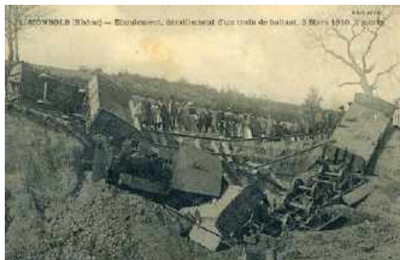
Carte postale de l'accident de train à Monsols en 1910, source Archives Municipales de Monsols
