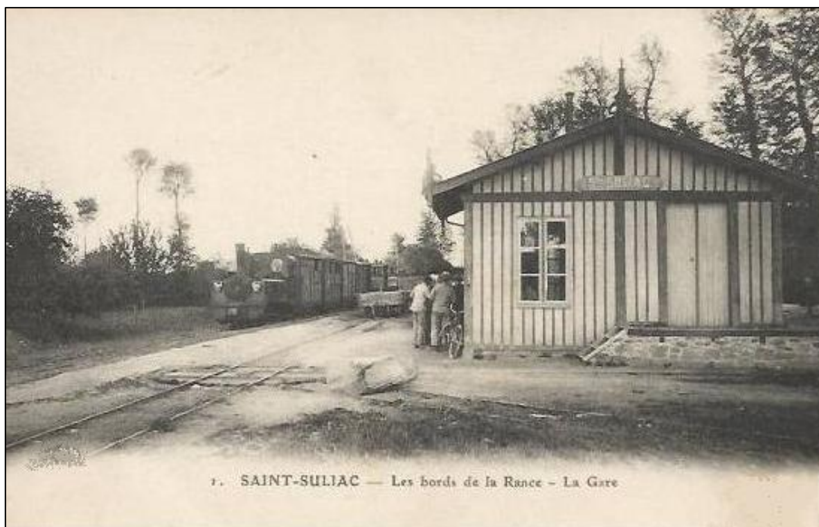
Figure 6 : La gare du tramway 44
