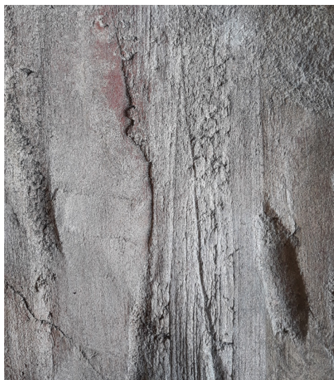
[fig.16] Échantillon de matière pour les parois du puits de la gare de Vitry © Louise Cousseau, BAP!
