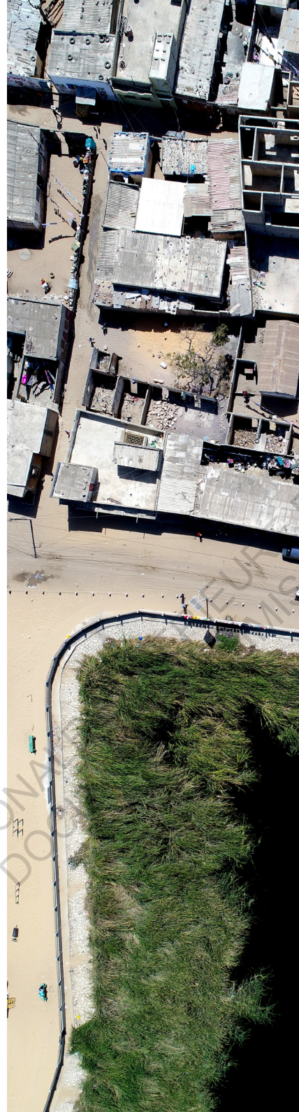
Bassin de rétention en partie envahi par le typha>
