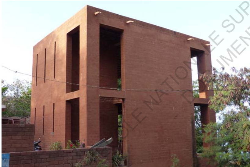
Chantier en BTC de L'Océanuim à Dakar
