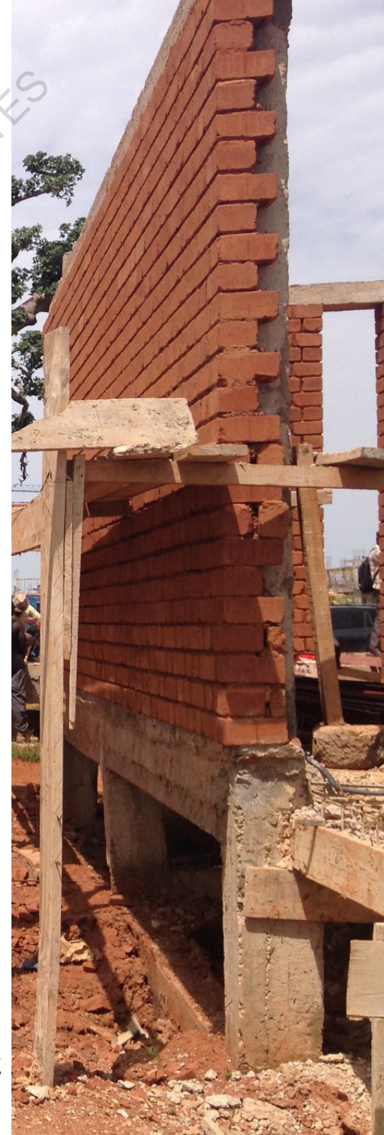
L'éco-pavillon terre-typha en septembre.> Les murs de BTC seront bientôt doublés de terre-typha
