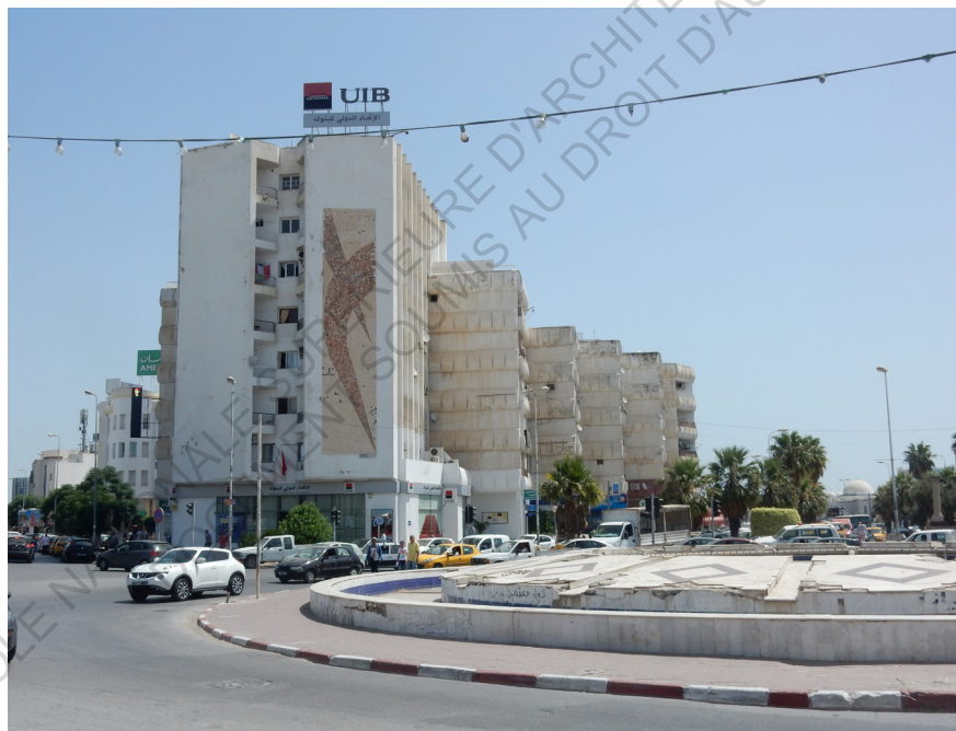
Figure 18 : La façade des immeubles HLM Crédit : Photo prise par moi le 06/08/2019
