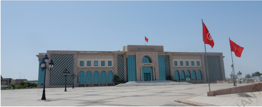
Figure 38 : Façade de l'hôtel de ville Crédit : Photo prise par moi le 06/08/2019
