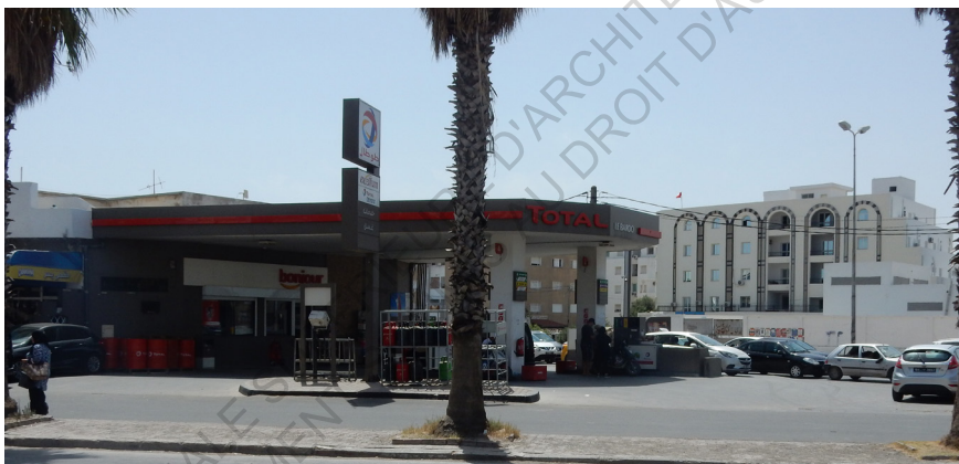
Figure 20 : La façade de la station-service Crédit : Photo prise par moi le 06/08/2019
