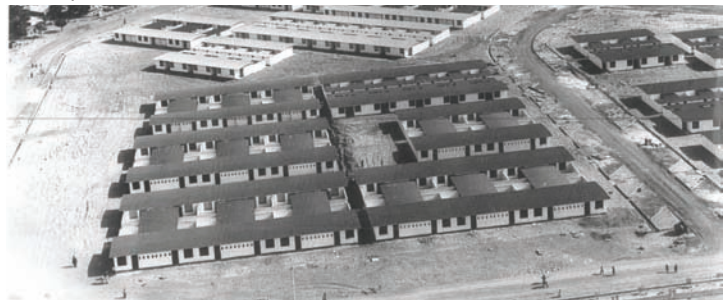
Logements économiques construit par la SOGEFIHA Source: AGEPA
