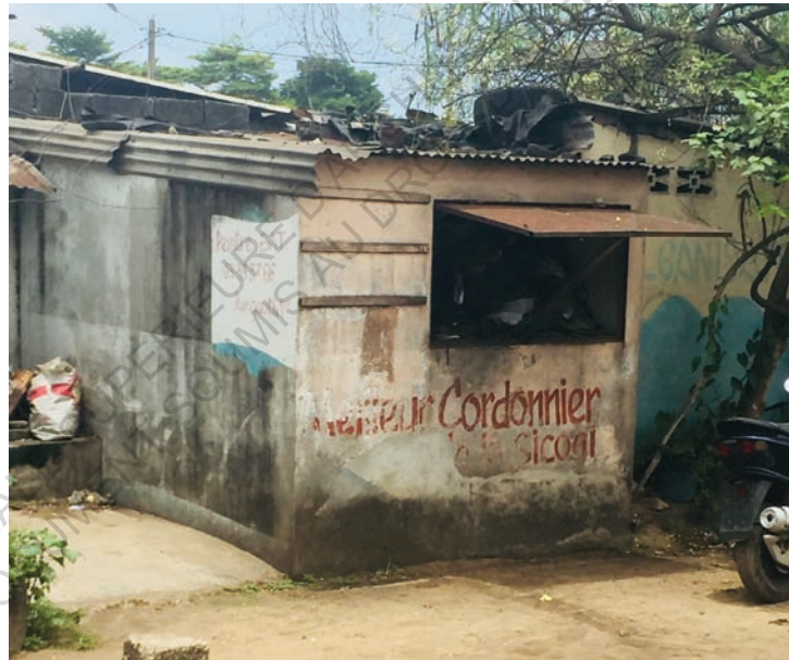
Extension de l'habitat pour la construction d'un atelier de cordonnerie Source : Eric Adjoumani
