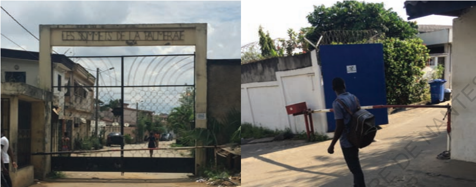
Accès de contrôle dans les citées programme 5 (Cocody-Riviera)
