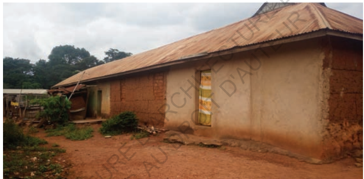
Mur en banco recouvert d'un enduit de ciment et d'une toiture en tôle Source: Photo Eric Adjoumani
