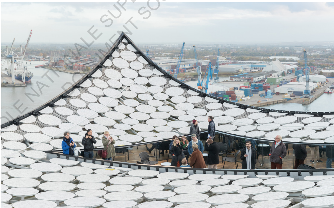
Terrasse en toiture
