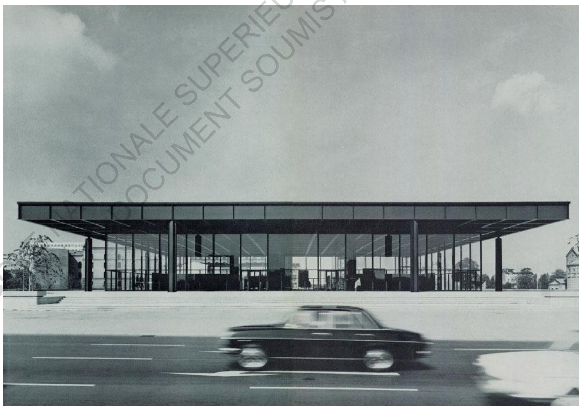
Vue depuis la rue Postdamer, 1968
