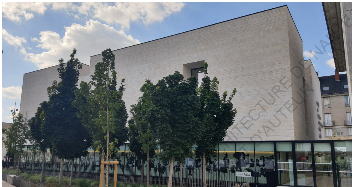
i.11 Vue Sud du nouveau bâtiment Source: photo personnelle de Juillet 2020
