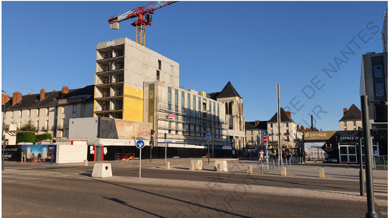
m.2 Photo Nord depuis la place très minérale Anatole France - en cours de chantier Source: photo personnel de Août 2020
