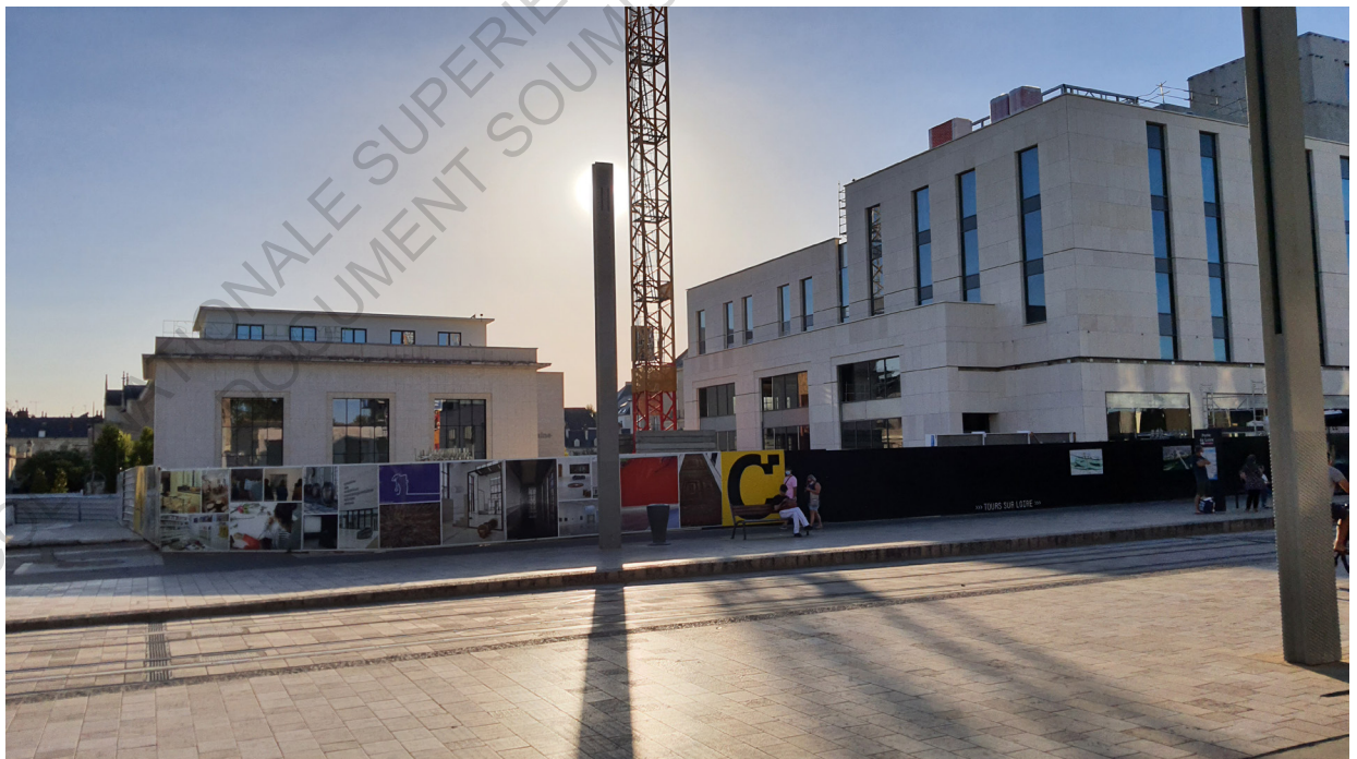
m.3 Photo Ouest vers le CCCOD - en cours de chantier Source: photo personnel de Août 2020
