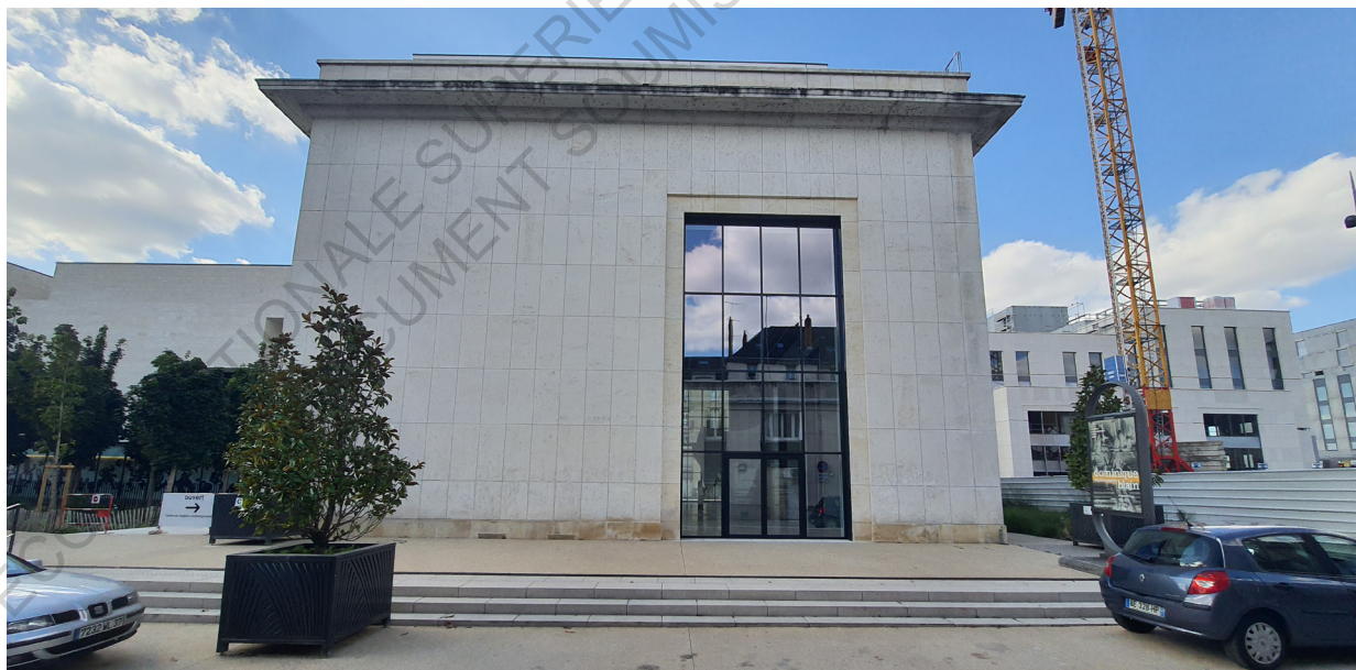
i.12 Vue Sud de la nef Source: photo personnelle de Juillet 2020
