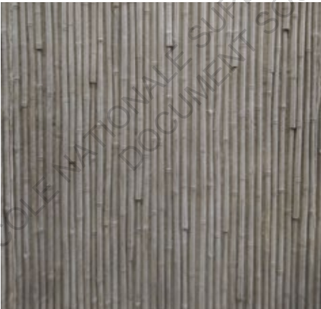
Voile béton matricié
