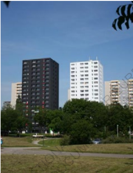
Réhabilitation des tours Aunis et Navarre par LATITUDE architectes (Jacques Gefflot & Marc Vitel)
