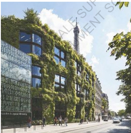
Facade végétalisée par Patrick Blanc
