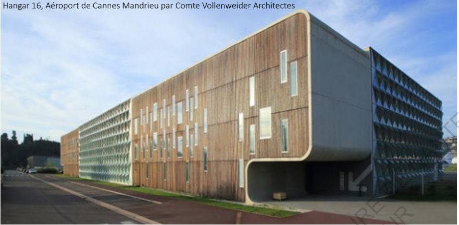
Hangar 16, Aéroport de Cannes Mandrieu par Comte Vollenweider Architectes
