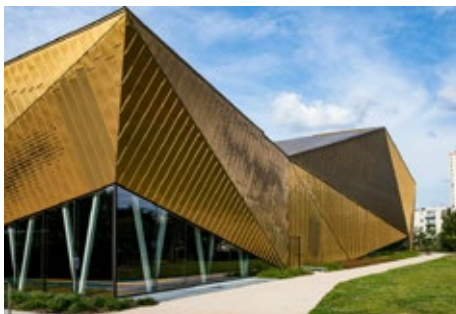
Complexe sportif La Fontaine-Beltrame à Antony par Tecnova Architecture & Archi5
