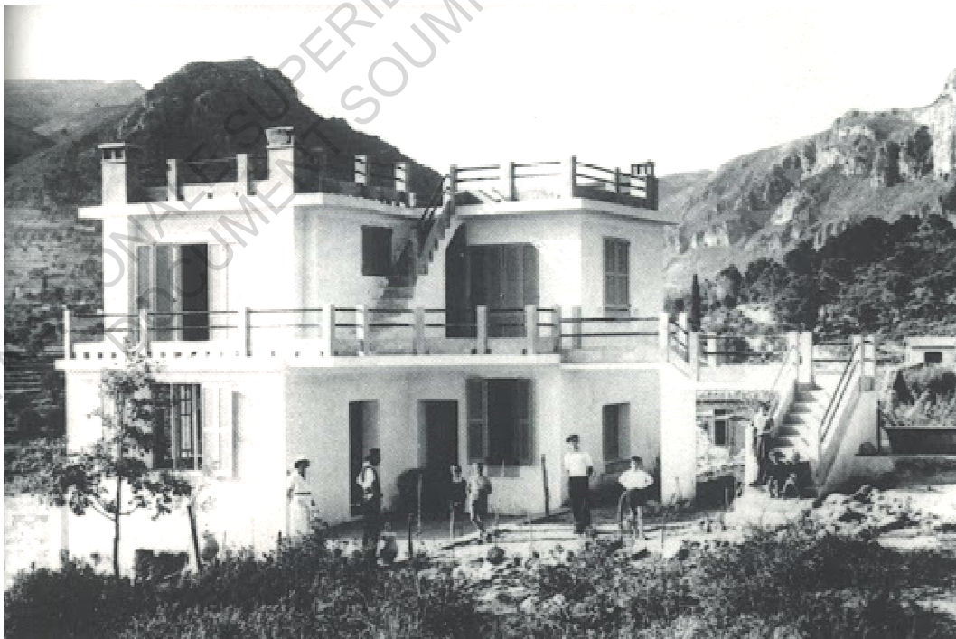
Figure 15 : Installation de l'école Freinet à Vence (Gard), en1935. Dossier documentaire constitué par la DRAC en 2001.
