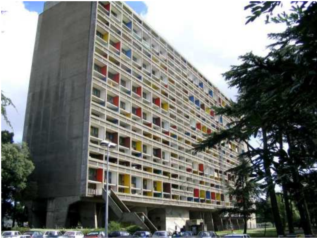
Figure 20 : La Maison radieuse de Rezé (44) construite par Le Corbusier en 1953-55. Le rapport à la nature est assuré par le parc.
