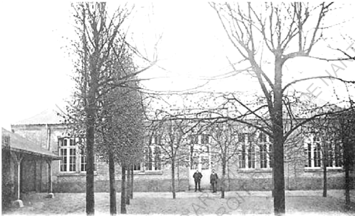
HALLENCOURT (Somme) — École Communale des Garçons
