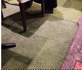
Revêtement de sol de restaurant / Nantes (44)
