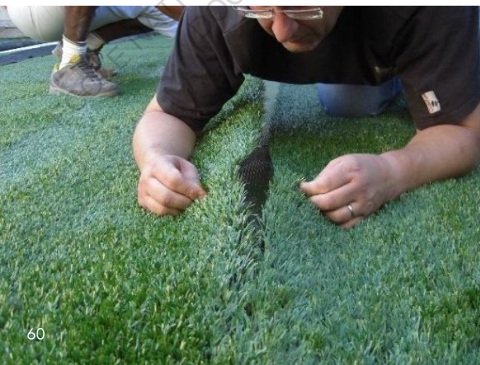
Pose de la pelouse synthétique par technicien de l'entreprise GAPE
