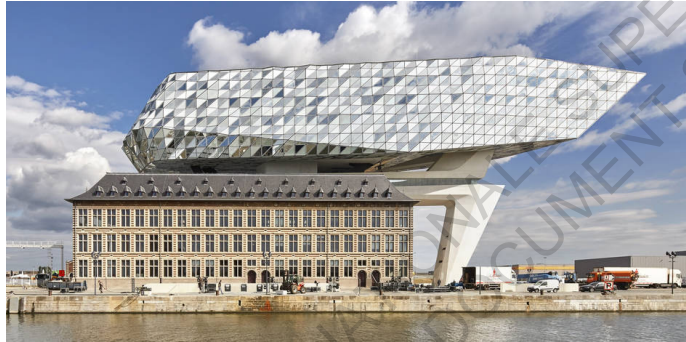
^ Havenhuis Zaha Hadid réalisé en 2012 à Anvers
