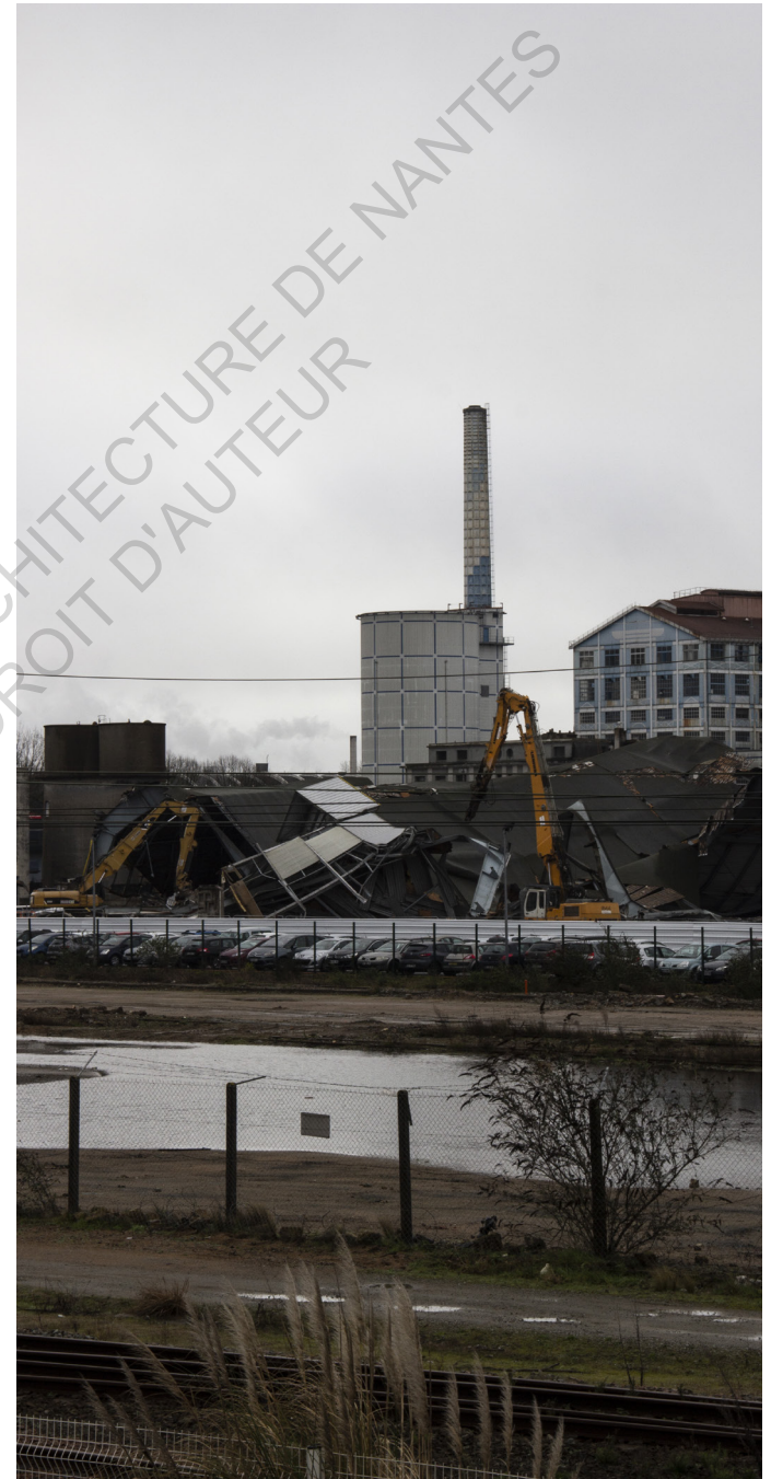
Chantier de démolition du MIN ^ 31 janvier 2020 ©Grégoire Chauvet
