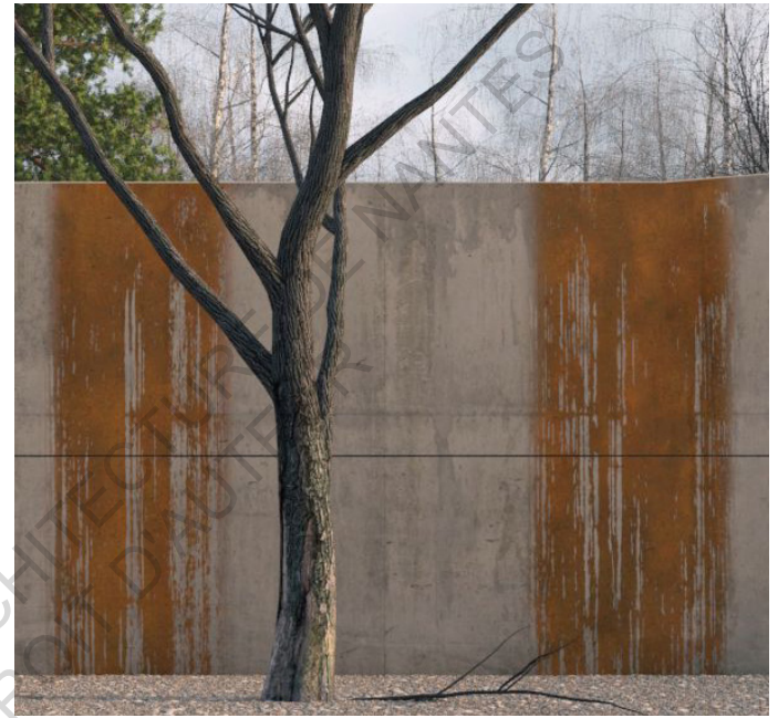
Mur extérieur de l'atelier de Remy Zaugg, ^ Herzog et De Meuron, Mulhouse, 1995
