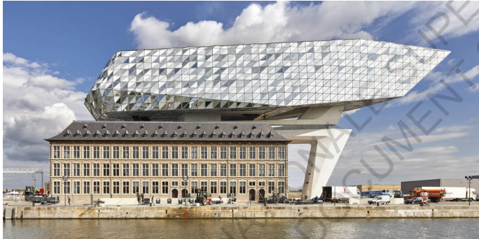
^ Havenhuis Zaha Hadid réalisé en 2012 à Anvers
