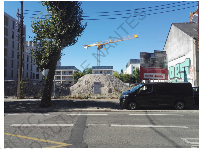
Chantier de démolition Boulevard de la Prairie au Duc
