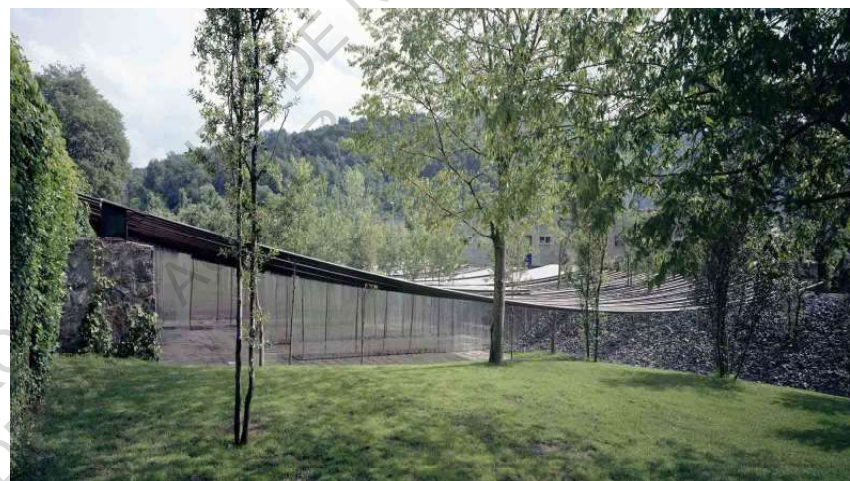
Fig. 22 Carpa en Les Cols : une couverture perforée d'arbres
