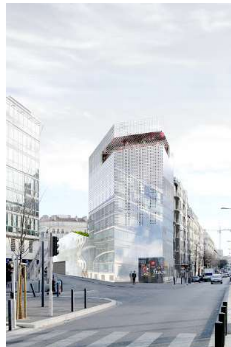
Fig. 98 EC2M architectes- FRAC PACA, Marseille - 2008
