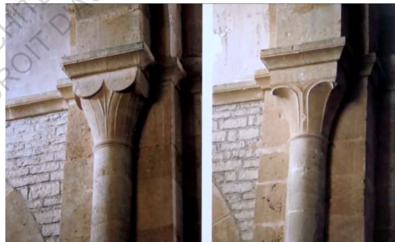
Fig. 2 Chapiteaux corinthiens de l'abbaye de Fontenay
