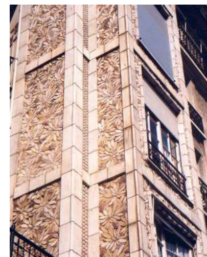
Fig. 11 Facade de l'immeuble rue Franklin de Perret
