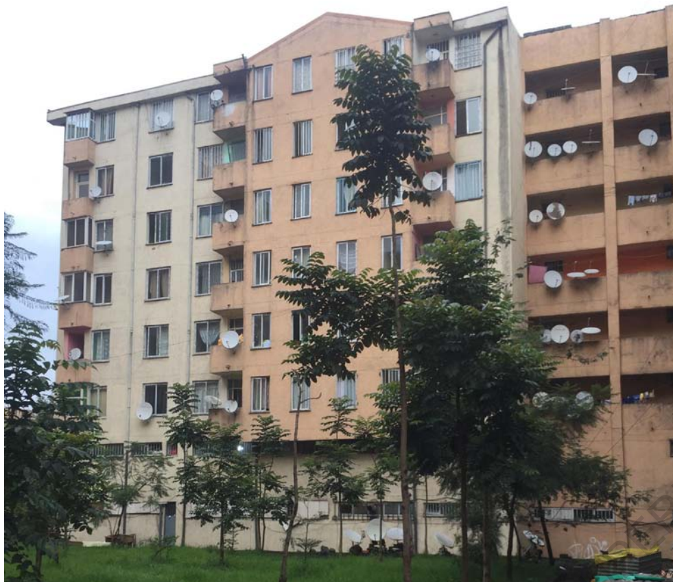
Condominium typique à Lideta, centre-ville.
