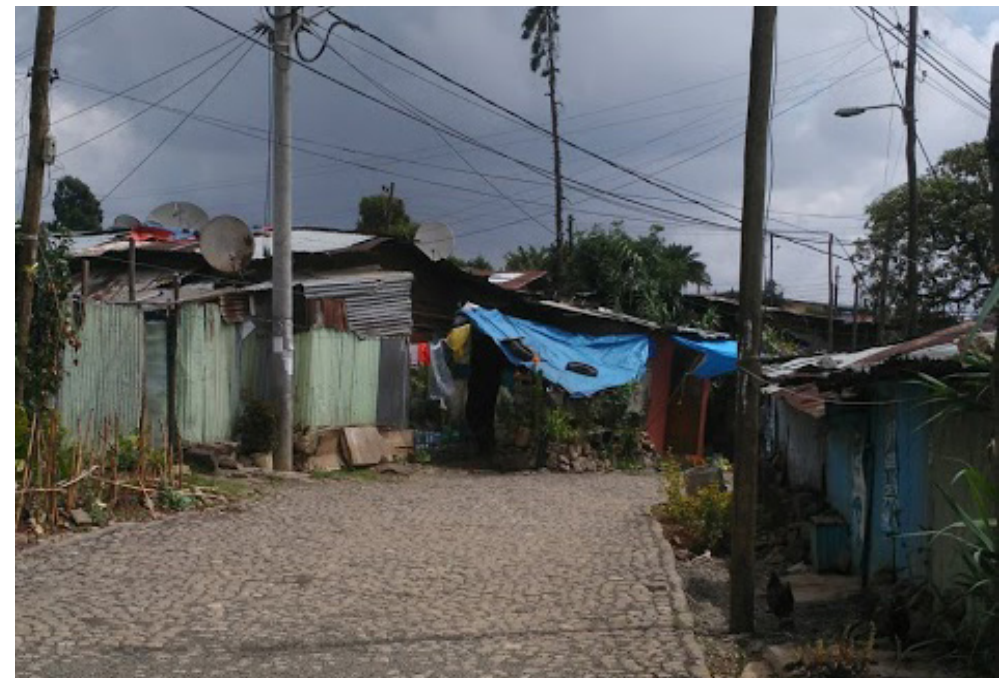
Quartier de maisons kebeles, des korkoro bets faits de tôle ondulée, de bois et de terre. Addis-Abeba.
