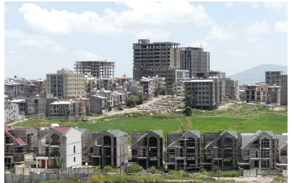
Construction de maisons mono-familiales pour des classes aisées, Summit, périphérie est de la ville.
